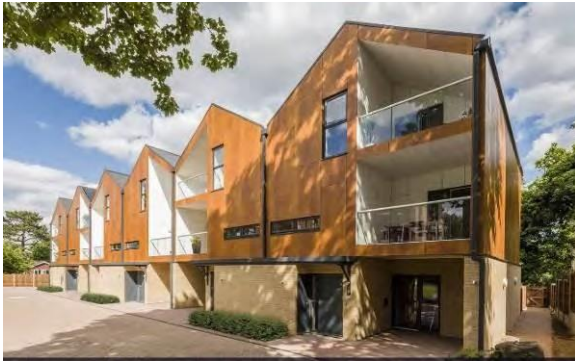
« Woodview mews » Upper Norwood, Londres Taylor Architects
