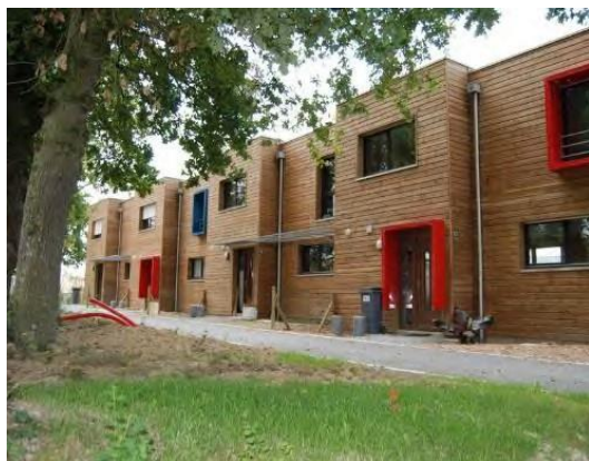
Vern sur Seiche (35) RIGOURD-HIAULT Architectes
