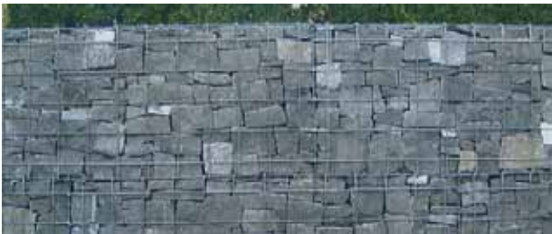
Des gabions comme alternative aux murs en pierres
