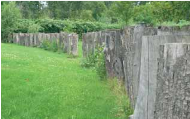
Des pieux de bois comme "clôture"
