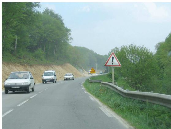
Entrée Ouest depuis Présentevillers. Une ambiance boisée omniprésente (altérée en mai 2004 par les travaux)
