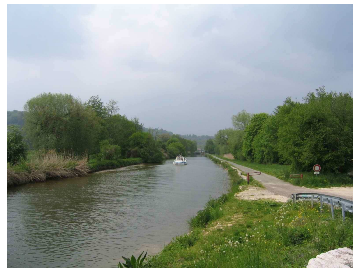
Le canal du Rhône au Rhin et ses berges bloquées et enherbées, très artificialisé.
