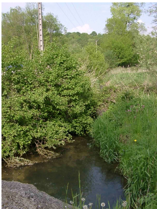
Le ruisseau du Moine le long de la route départementale D33 : le lit mineur est étroit et canalisé par la mise en place de buses.
