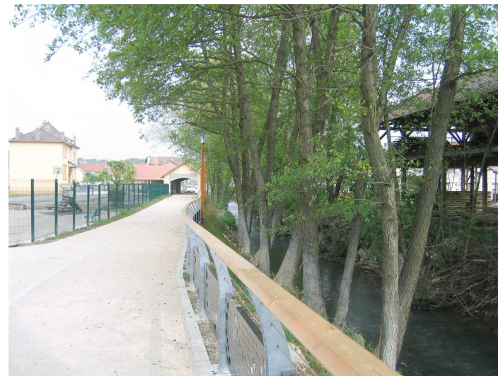
Piste cyclable en rive gauche du Rupt : un aménagement récent en site urbain qui assure de bonnes connexions entre les différents quartiers et équipements publics de la commune de Bart .
