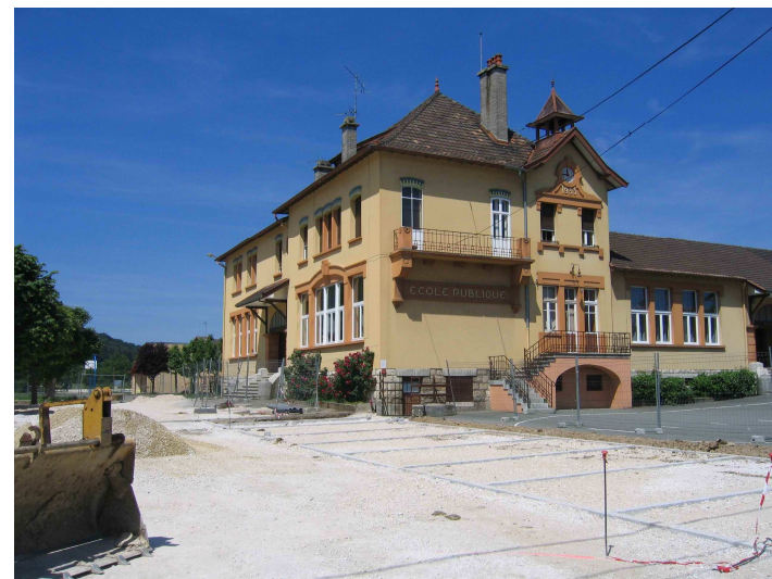
Belle bâtisse réhabilitée accueillant le groupe scolaire Jules Ferry
