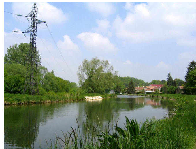
Le canal du Rhône au Rhin et ses berges artificialisées ne permet pas le développement d'habitats de qualité.
