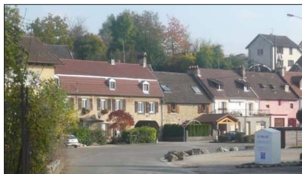
Cités ouvrières construites en 1920
