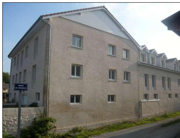
Ferme Wurgler rénovée
