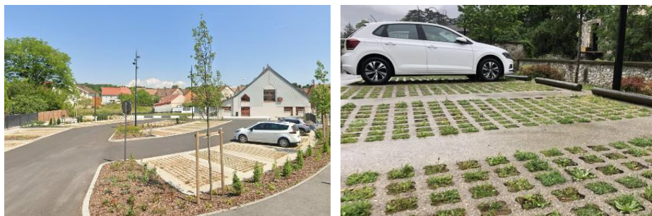
Exemples de revêtement drainant pour stationnements à Dasle et Proverville
