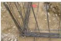
Nœud de chaînage - Continuité mécanique
