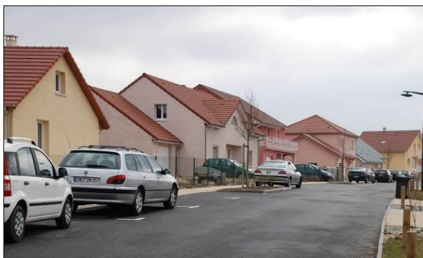
Lotissement de maisons individuelles rue Cl. Nougarot
