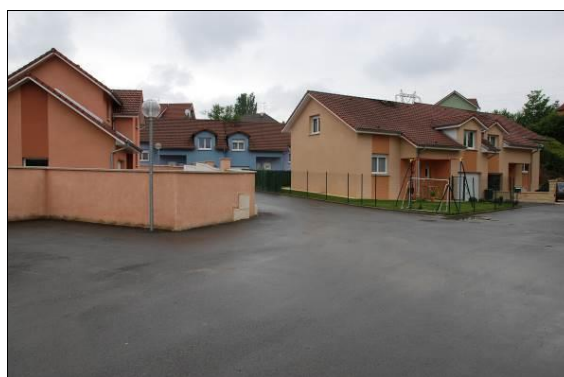
Maisons individuelles groupées rue Marcel Paul
