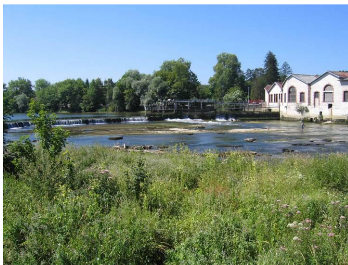
Barrage sur le Doubs et bancs de graviers occupés par une végétation pionnière herbacée
