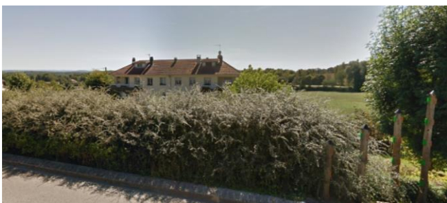
Unique construction de type « petit collectif » en zone UB
