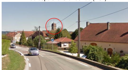
Vue depuis la Grande rue (D67)
