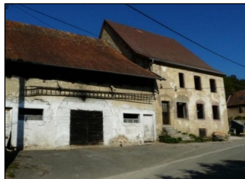
Figure 2 : La ferme Muller en cours de rénovation en 2011
