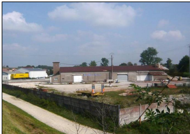
Figure 4 : Les bâtiments d'activités au Breuil
