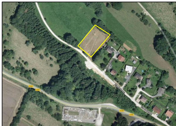
Figure 18 : Bassin de rétention réalisé par P.M.A. en 2007
