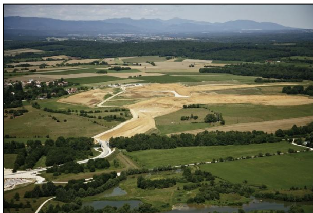
Figure 20 : Vue sur les travaux en cours sur Technoland 2, en 2010
