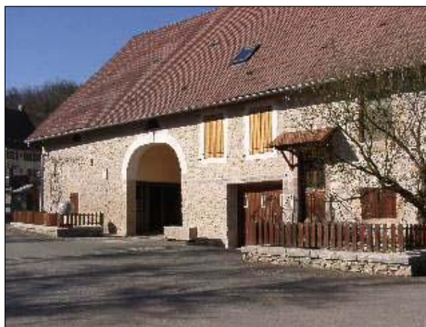
Figure 14 : Ancienne ferme réhabilitée
