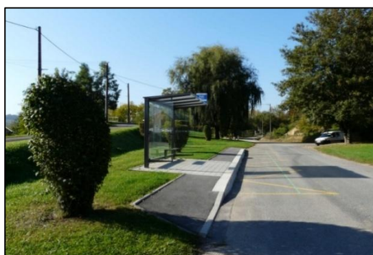
Figure 10 : Arrêt de bus « Moulin du Bois »
