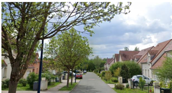
Exemple d'aménagement de voirie : quartier du Vallon des Jonchets à Grand-Charmont (source : ADU)
