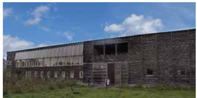
Utilisation des énergies renouvelables
