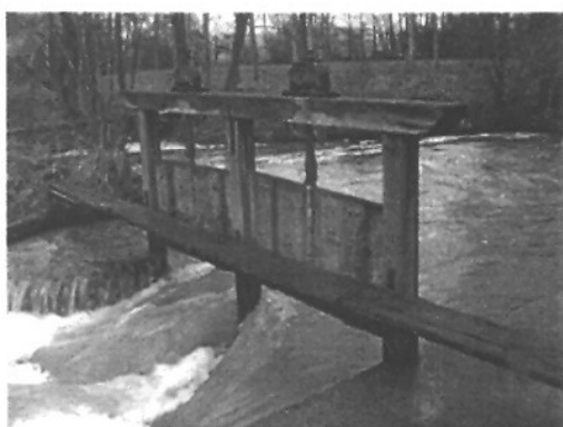
Vannes de Pertuis Bras du Vrïn des Marchands
