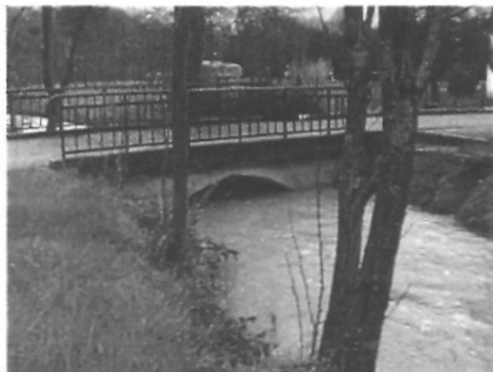
OH9 - Passage sous la rue de l'Amandier
