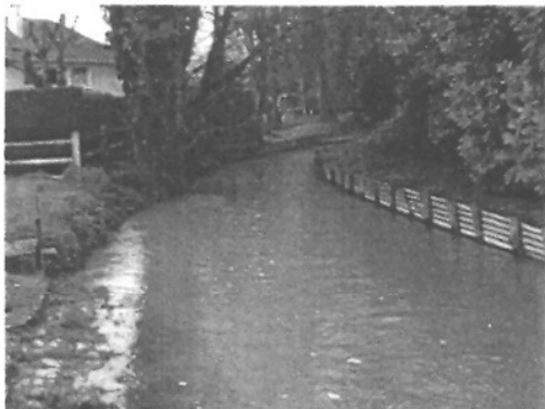
Vue à l'amont du carrefour entre les rues des Buttes, de la Vanne et du 6 Juin 1944
