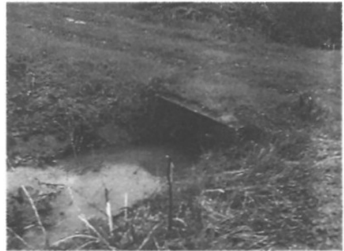
Dérivation du bras des Moulins vers celui des Marchands en amont de la RD 182
