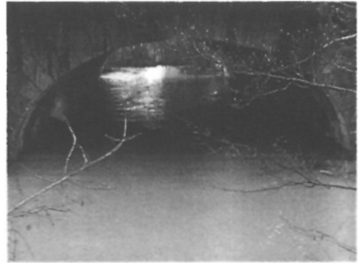
OH4' - Passage sous la voie ferrée
