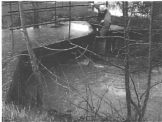
Ouvrage le long du chemin rural de Presle permettant accès aux jardins et habitations rive droite
