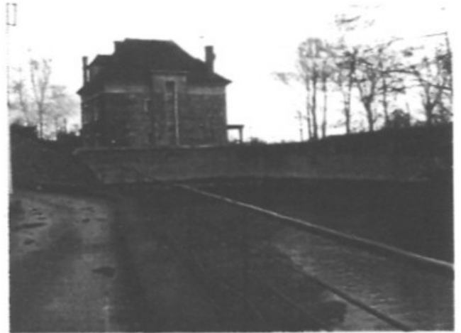
Extrémité de la rue du Moulin d'en Bas (vue vers l'aval)
