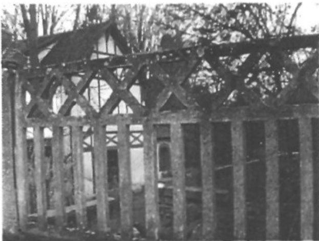
Habitation n°21bis rue du Moulin d'en Bas inondée lors de la crue de l'Yonne
