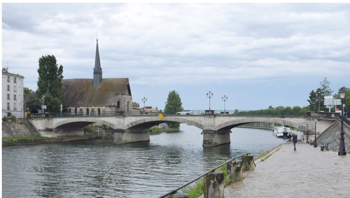
A Sens, le pont de l'Yonne et du quai Ernest Landry mettent en valeur la rivière au cœur de la ville
