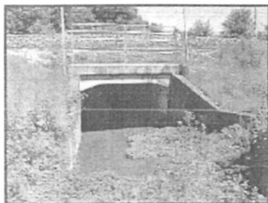
Aval OH 16 : Voie de Chemin de fer
