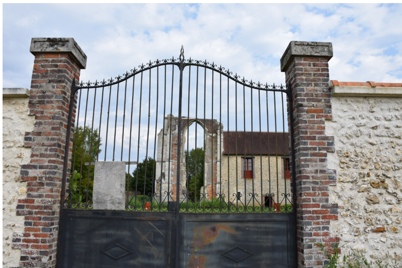
Exemple de clôture à préserver : murs en pierre apparente avec couronnement pentu, piliers en briques et portail ajouré ferronné.
