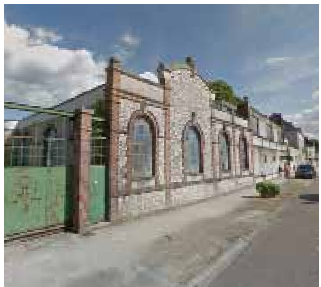
Un potentiel de renouvellement urbain au nord de Villeneuve-sur-Yonne.
