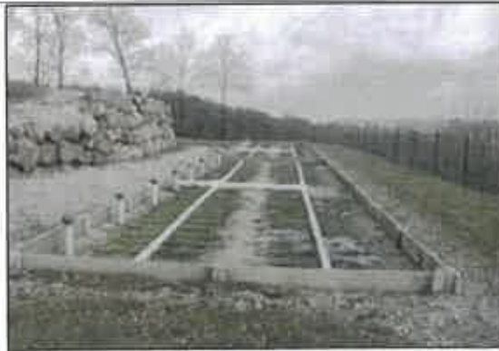
Photo 32 : Filtre de second étage
