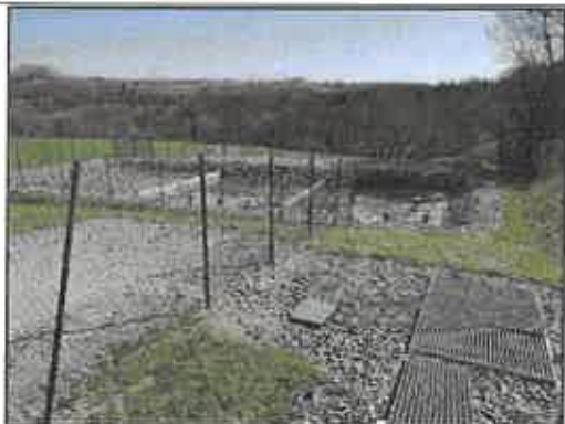
Photo 45 : Vue d'ensemble de la station d'épuration
