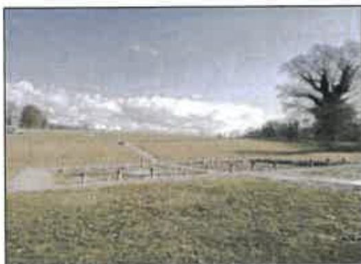
Photo 23 : Vue d'ensemble de la station d'épuration
