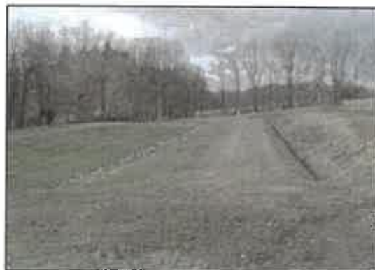
Photo 20 : Filtre à sable
