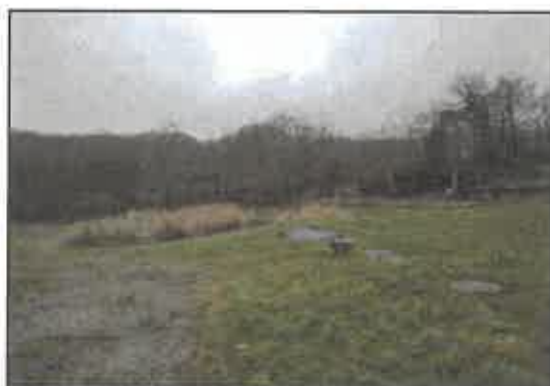
Photo 41 : Vue d'ensemble de la station d'épuration
