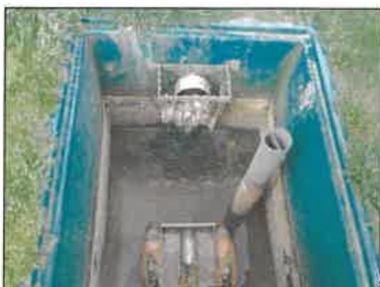
Photo 15 : Chasse de premier étage avec dégrilleur intégré
