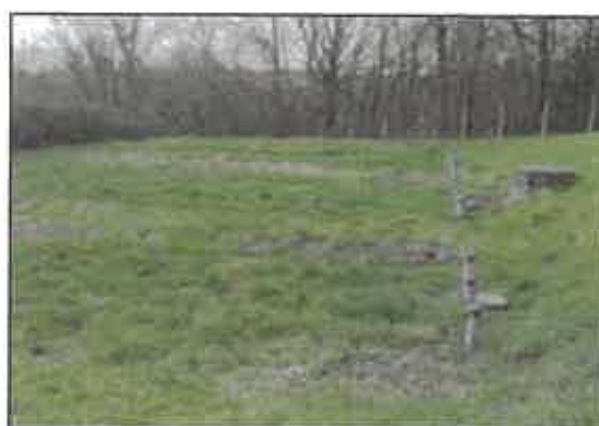
Photo 22 : Filtre à sable
