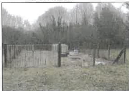
Photo 39 : Vue d'ensemble de la station d'épuration
