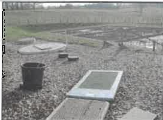
Photo 25 : Vue d'ensemble de la station d'épuration
