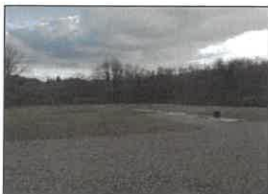
Photo 27 : Vue d'ensemble de la station d'épuration
