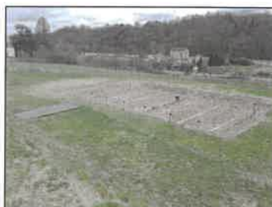
Photo 16 : Filtre de second étage
