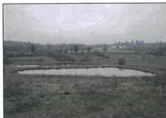
Photo 43 : Vue d'ensemble de la station d'épuration
