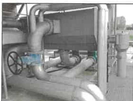
Photo 3 : Tamis rotatif et by-pass
