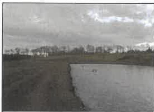
Photo 19 : Vue d'ensemble des lagune
