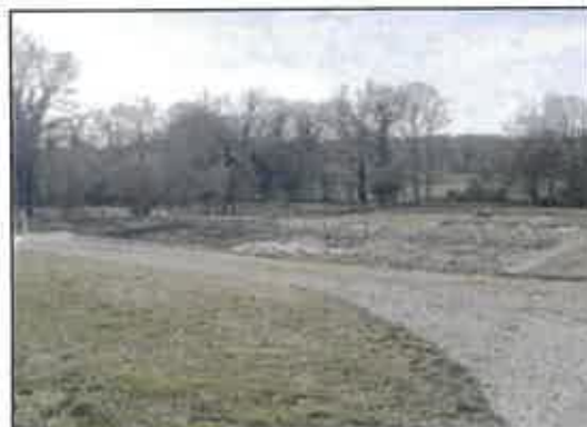
Photo 24 : Filtre du 1 er étage
