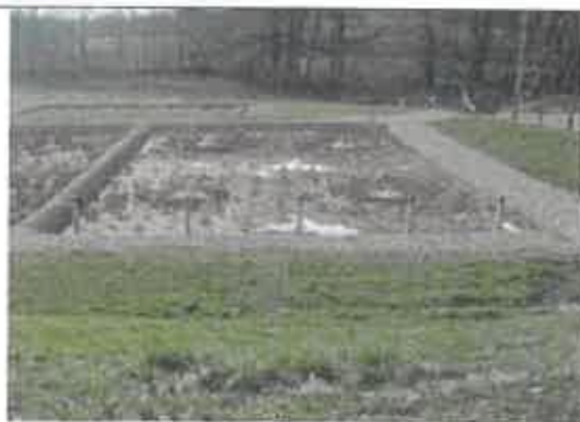
Photo 26 : Filtre du 1 er étage
