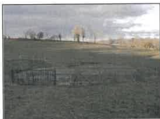
Photo 17 : Vue d'ensemble du filtre planté de roseaux
