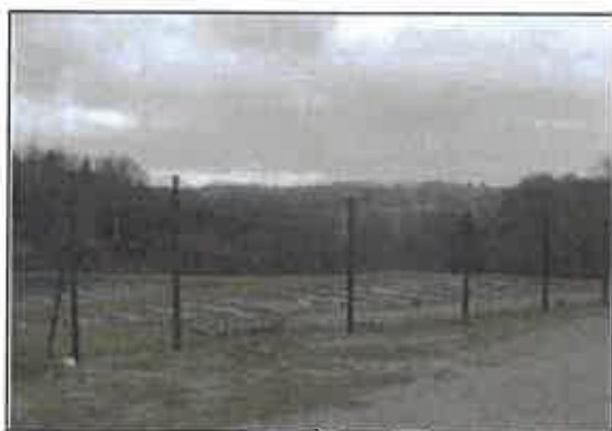
Photo 29 : Vue d'ensemble de la station d'épuration
