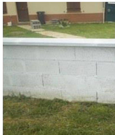
MUR DE CLOTURE NON ENDUIT
