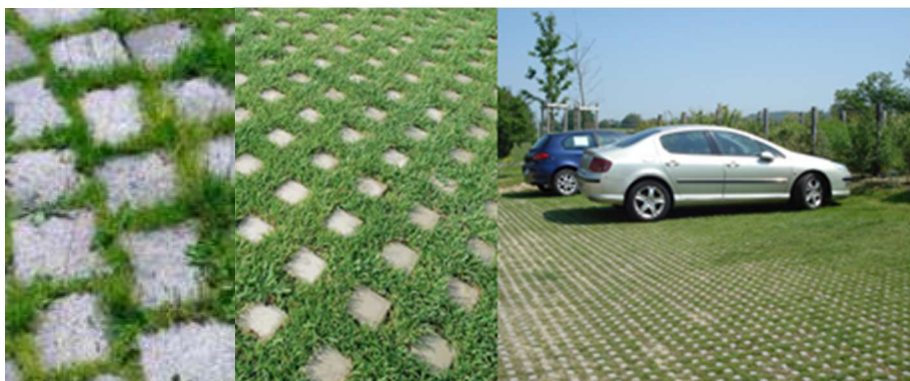
Exemples de traitement respectueux de l'environnement : pavés enherbés limitant la perméabilité des sols
