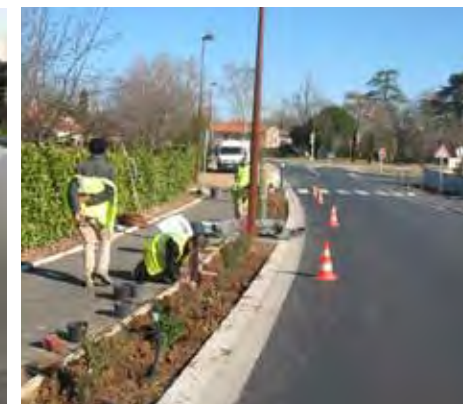
Mise en place d'une bordure plantée pour sécuriser les déplacements de cycles, Marssac-sur-Tarn (81)
