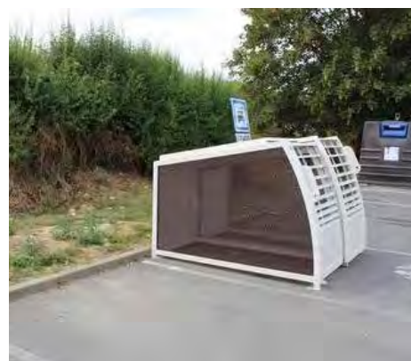
Local vélo sécurisé sur aire de covoiturage, Lesigny (77)
