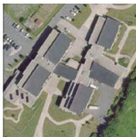
EHPAD, les Collines à Pouzauges
