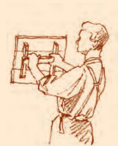
▲ la taloche pour serrer l'enduit.
