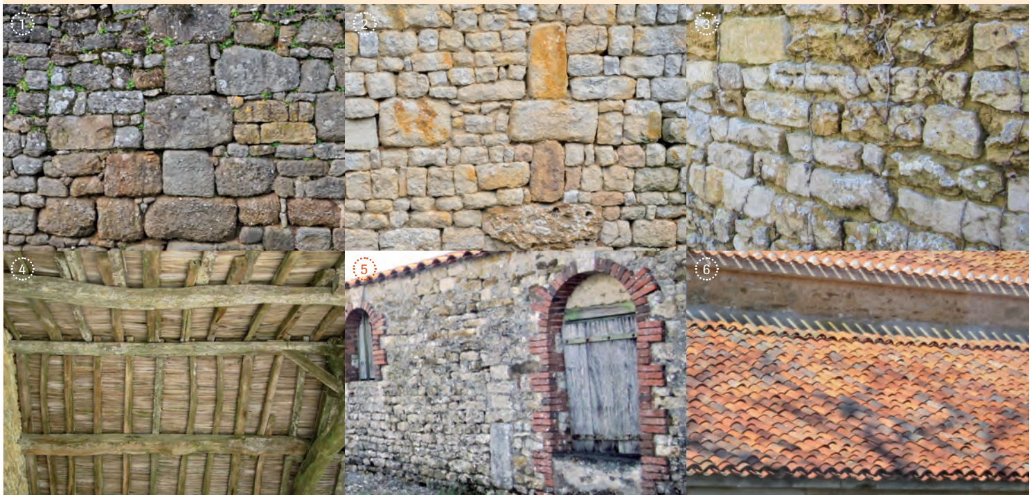
1, 2 & 3 : Murs en pierre locale. / 4 : Charpente en bois sur une grange en pierre calcaire. / 5 : Encadrement en tuile et mur en calcaire. / 6 : Toiture en tuiles canal et corniche en calcaire.
