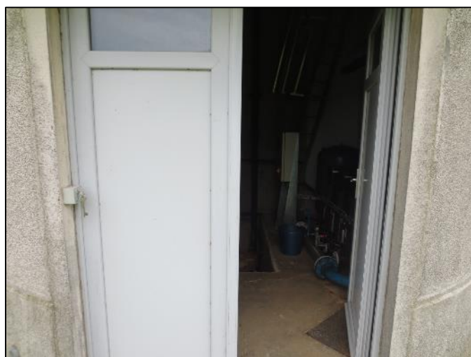
5. Porte d'entrée verrouillée (PVC)
