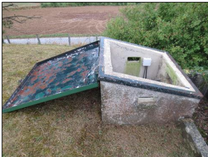
15. Trappe d'accès à la cuve. Capôt verrouillé avec rebords
