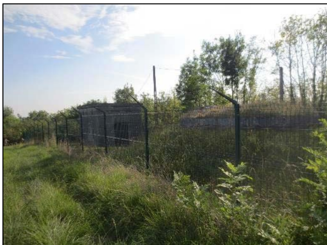
1. Vue générale du site ; clôture de 2 m en panneaux rigides avec barbelés
