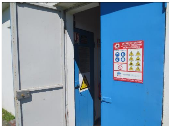
3. Porte d'entrée du local de commande
