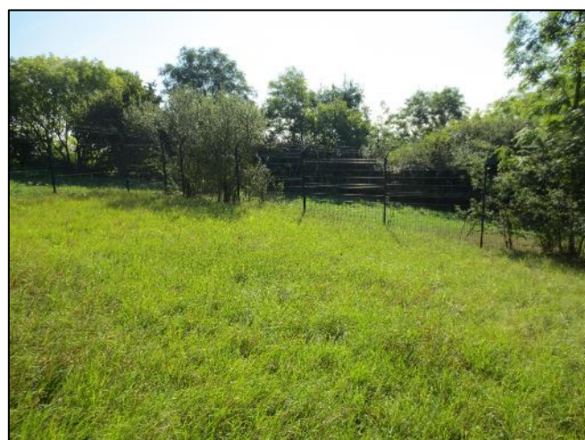
4. Abords bien entretenus et clôture en bon état
