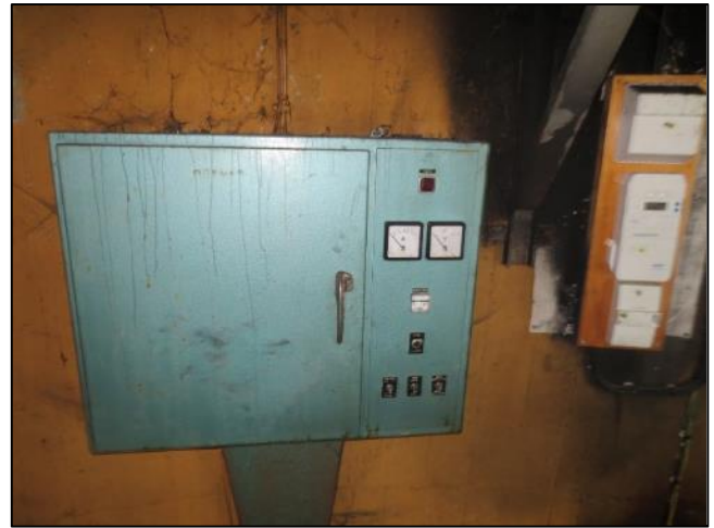
9. Ancienne armoire électrique
