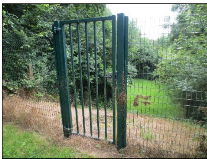
2. Clôture rigide et portillon de 2 m de haut en bon état
