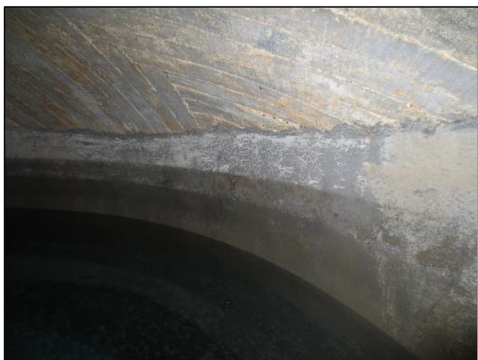
9. Cuve de droite : Voile de cuve et intrados en bon état apparent
