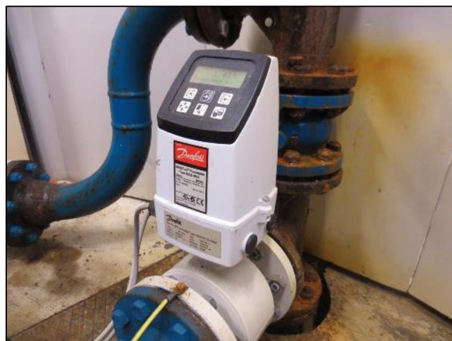
14. Débitmètre électromagnétique Grundfos
