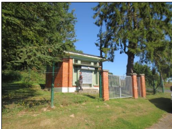
1. Vue générale du site clôturé
