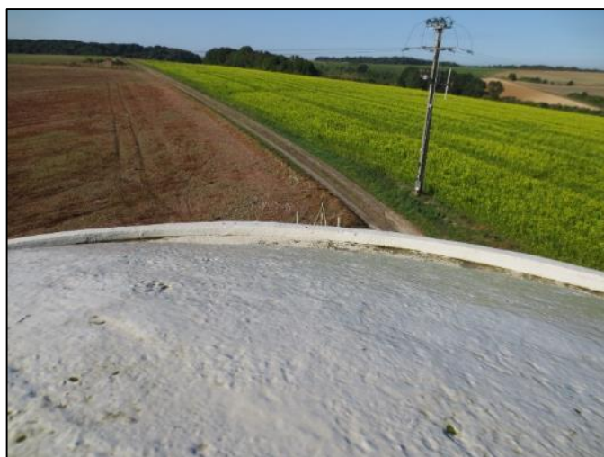
31. Revêtement du dôme en bon état
