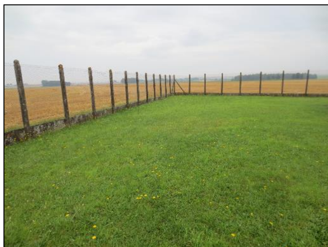
3. Clôture en bon état et abords bien entretenus
