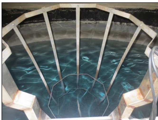
23. Echelle avec crinoline d'accès en fond de cuve
