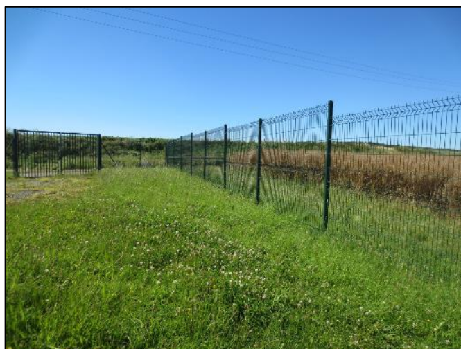
2. Clôture rigide de 2 m de haut en bon état ; abords bien entretenus
