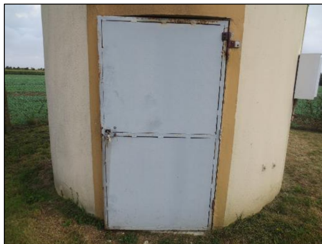
6. Porte d'entrée du réservoir
