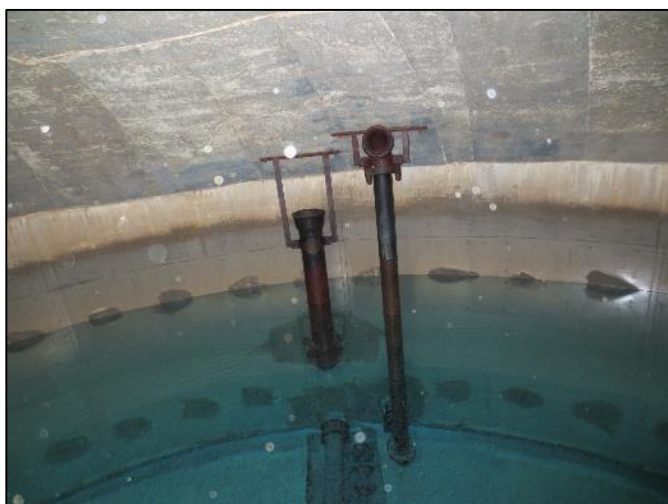
24. Refoulement et trop-plein ; Voile et intrados en bon état apparent
