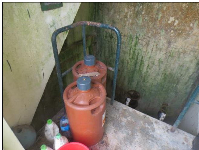
8. Garde corps et stockage de matériel
