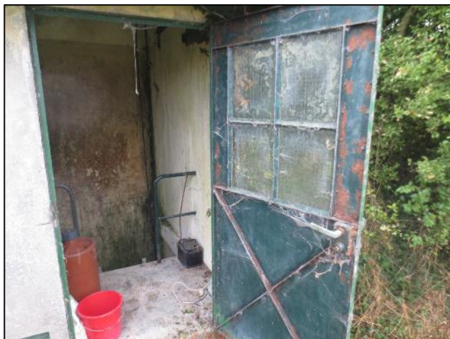
7. Porte d'entrée de la chambre de vannes
