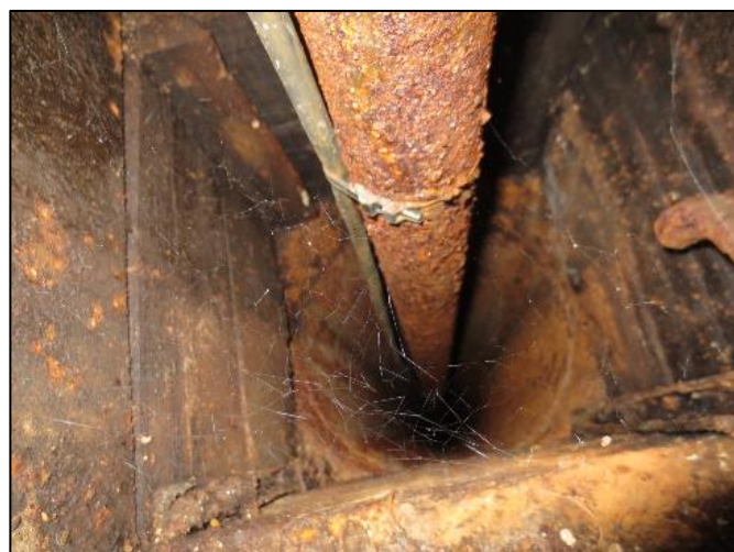
9. Vue intérieure du puits
