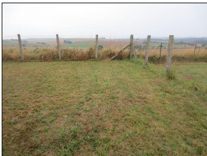
3. Abords bien entretenus ; clôture souple en bon état
