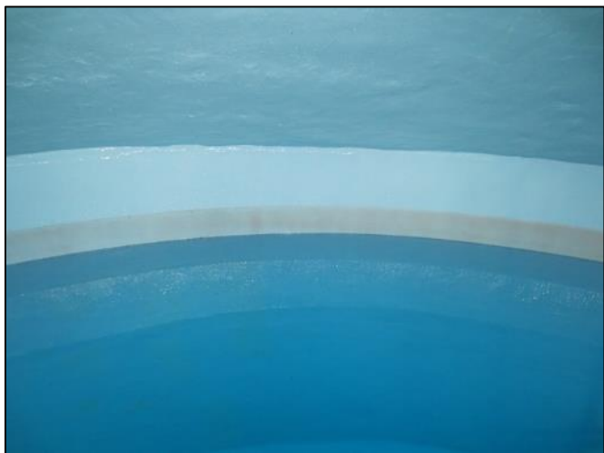
28. Voile de cuve et complexe d'étanchéité en bon état apparent
