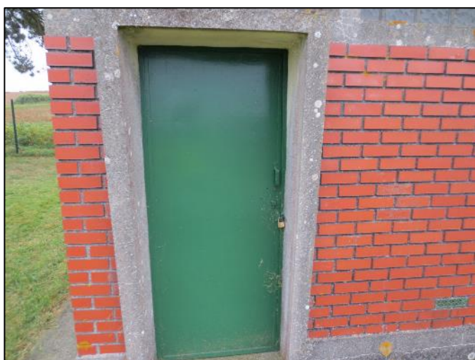
5. Porte d'accès au local électrique
