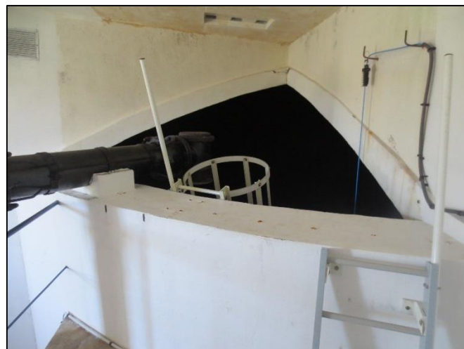
13. Accès cuve de gauche
