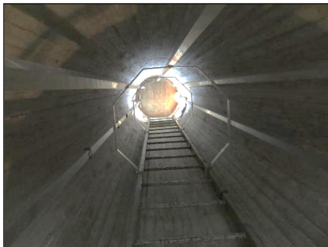
15. Trou d'homme d'accès à la cuve
