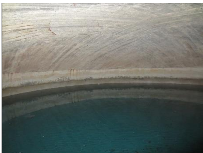
21. Bon état apparent de l'intrados
