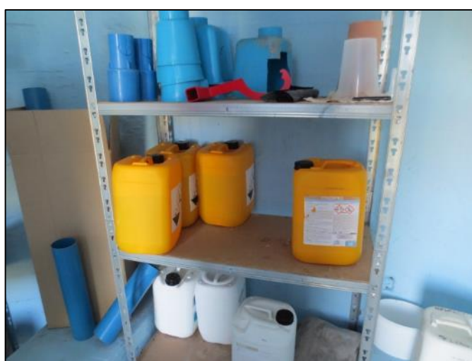
12. Stock des réactifs de traitement (Chlorpro et Détarpro)
