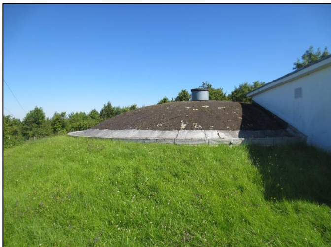
3. Cuve gauche : revêtement extérieur paxalumin
