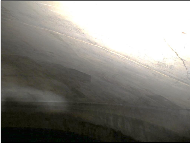
17. Cuve gauche : Voile de cuve et intrados en bon état apparent
