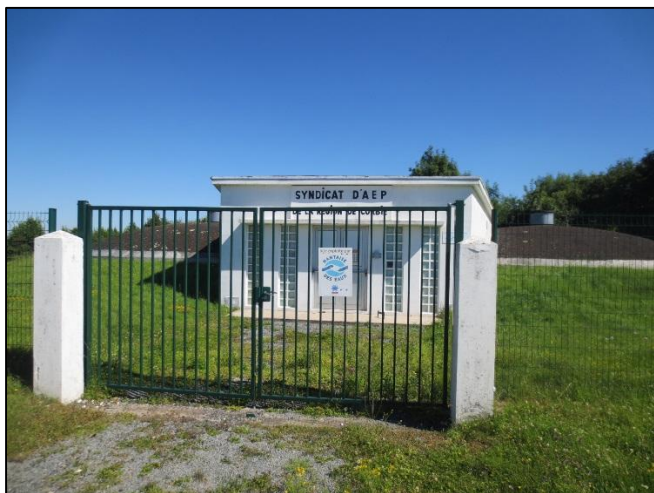
1. Vue générale du site ; Portail double vantaux verrouillé lors de la visite
