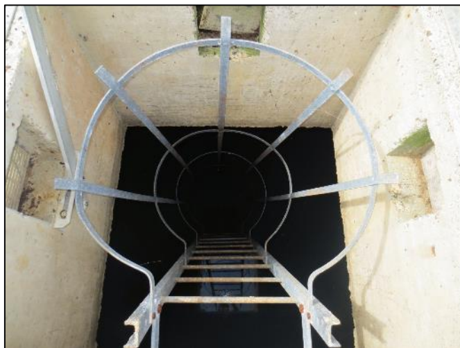
23. Echelle avec crinoline d'accès au fond de cuve
