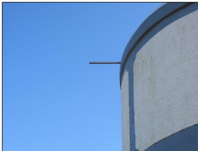
8. Evacuation des eaux de pluie du dôme par barbacanes
