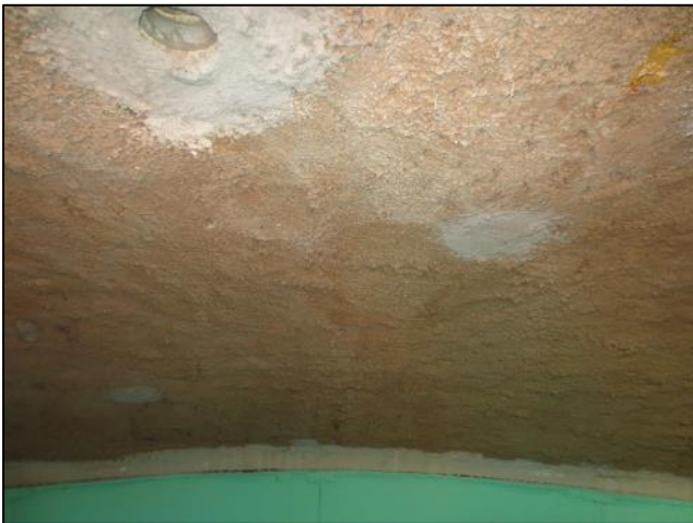
24. Intrados en ciment avec crépis
