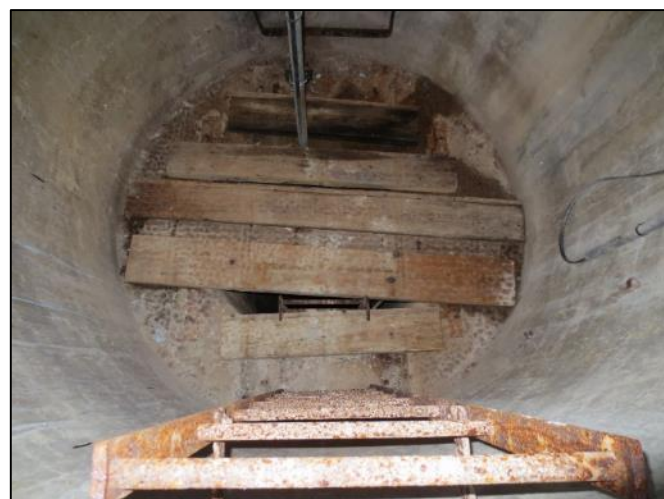
20. Ancien puits (sous capot aluminium de protection)
