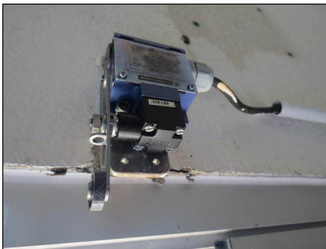
6. Dispositif anti-intrusion de la porte d'entrée
