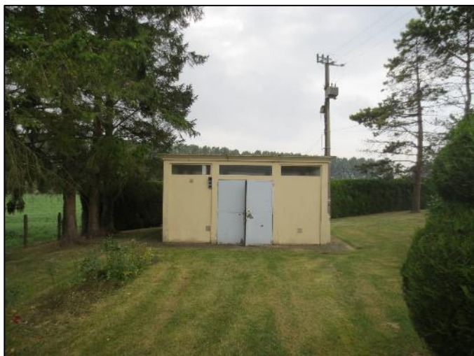
1. Vue générale du site clôturé avec portail verrouillé
