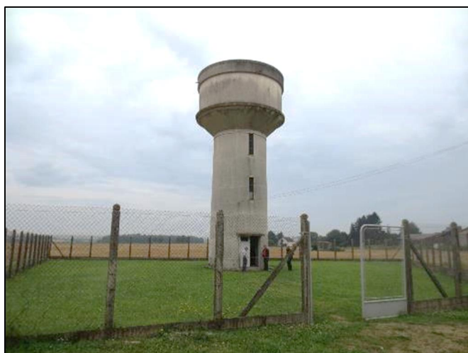
1. Vue générale du site clôturé
