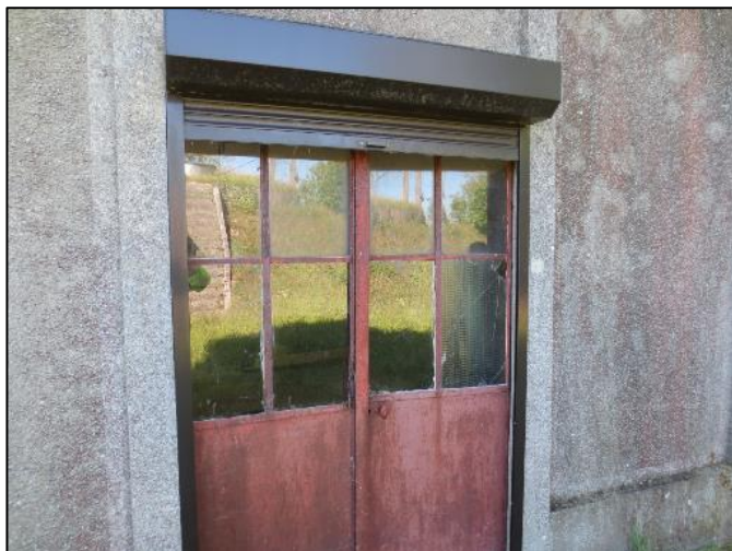
6. Porte d'entrée vitrée du bâtiment protégée par un volet roulant verrouillé
