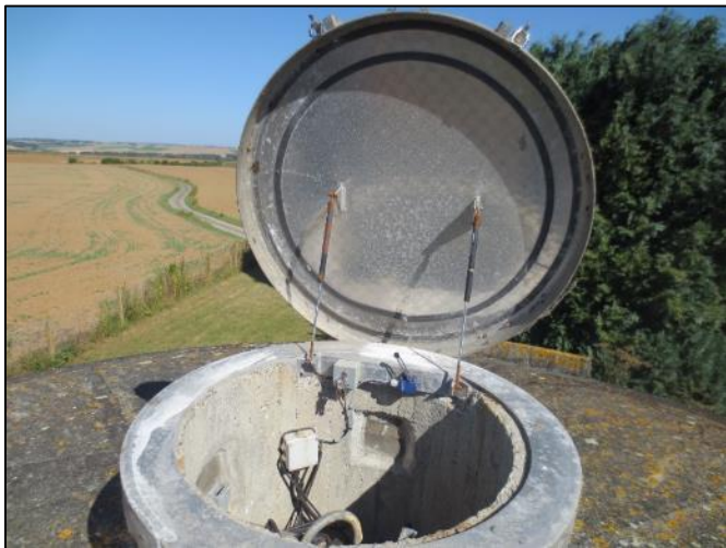
8. Regard d'accès à la cuve
