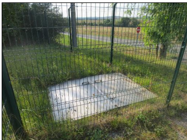
3. Chambre de vannes
