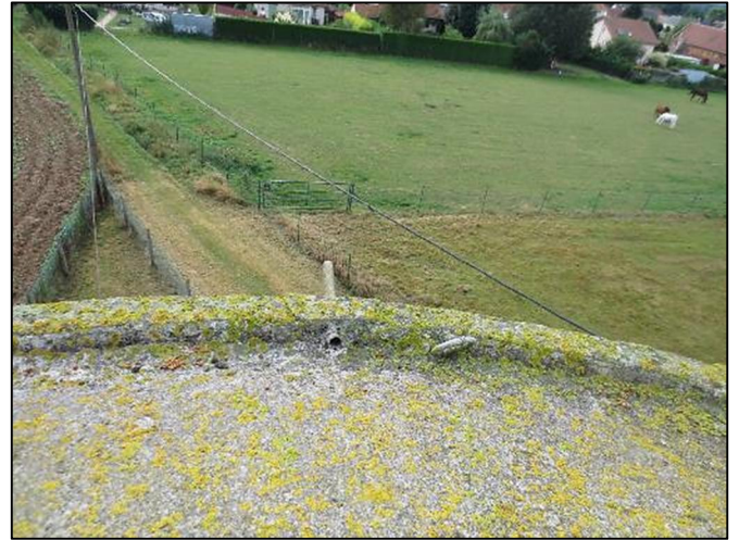
28. Dôme couvert de lichen ; évacuation des eaux de pluie vers l'extérieur via des barbacanes
