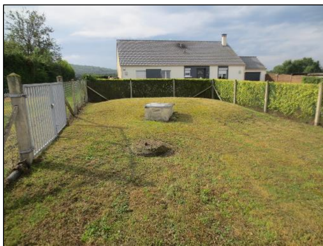
2. Bâche enterrée de 5 m 3 ; abords bien entretenus
