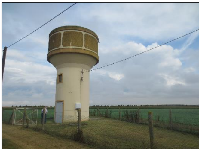
1. Vue générale du site
