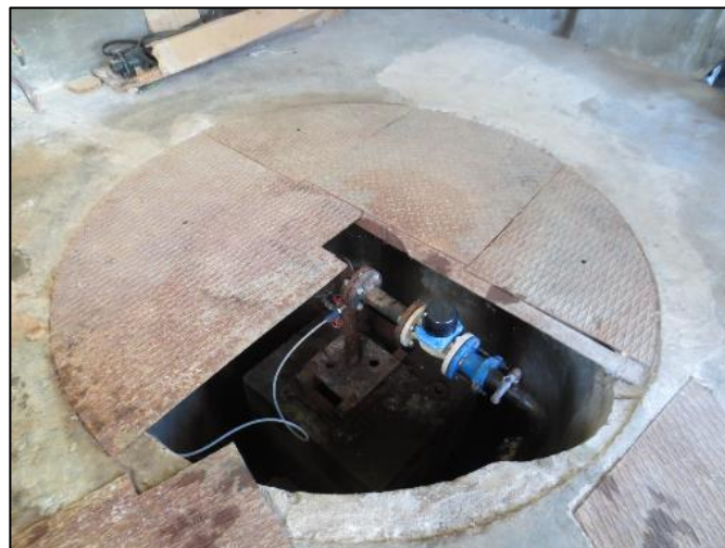
7. Accès à la tête de puits
