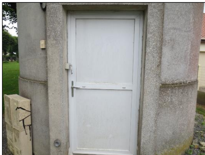
2. Porte d'entrée (PVC)
