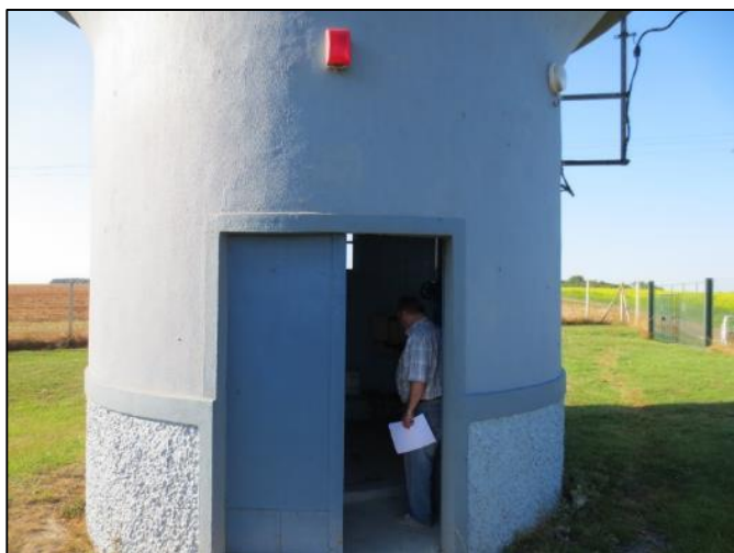
9. Porte d'entrée refaite
