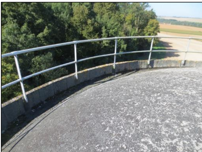
14. Acrotère avec garde-corps
