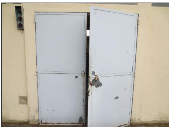
4. Porte d'entrée du local
