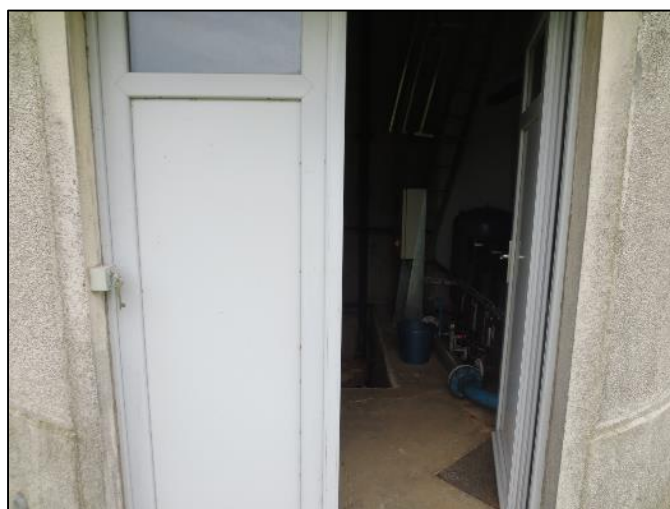
5. Porte d'entrée verrouillée (PVC)
