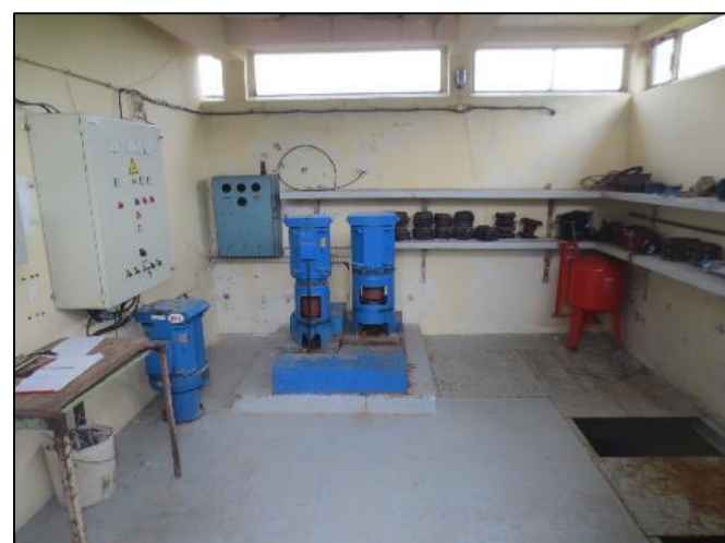
5. Vue générale de l'intérieur du local ; stock de matériel de robinetterie
