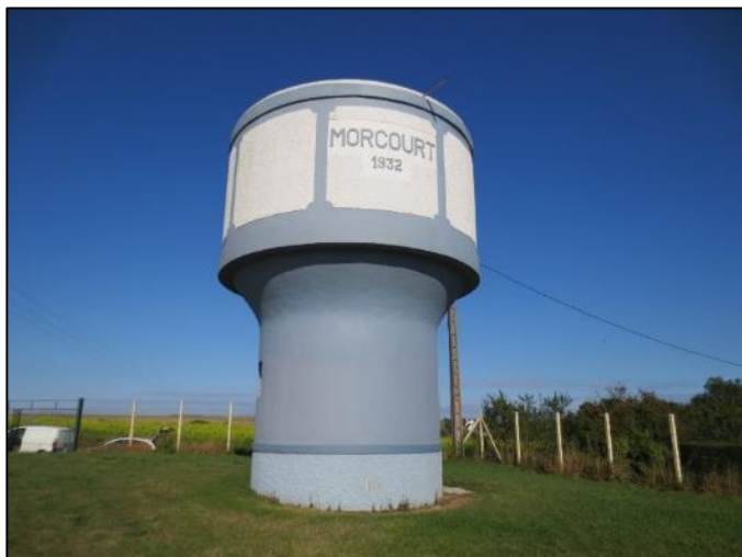
7. Très bon état extérieur du château d'eau
