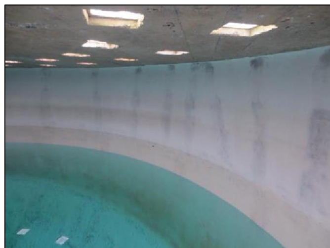
22. Bon état apparent des bétons du voile et du plafond
