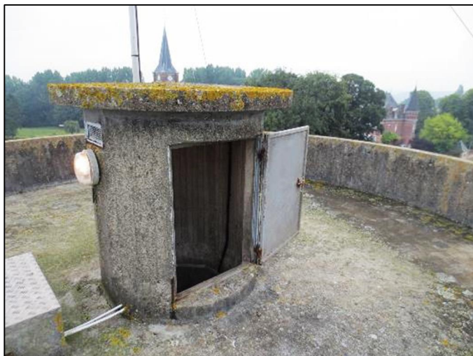
16. Accès au dôme et à la cuve par un édicule
