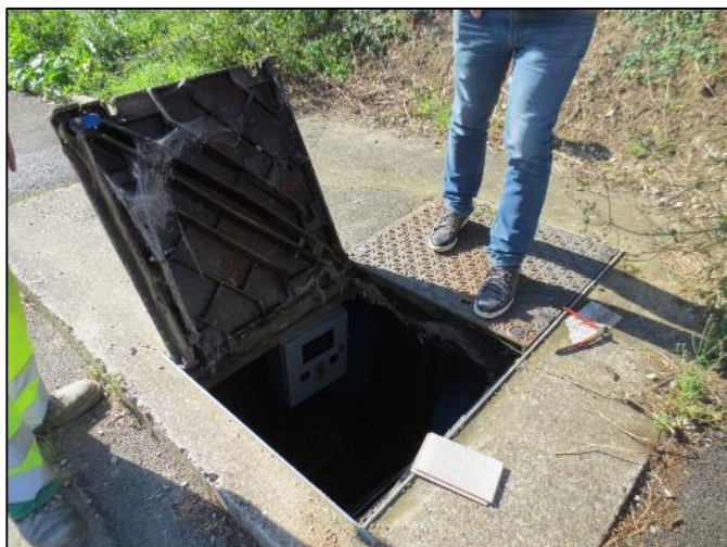
1. Ouvrage en accotement ; tampons fonte
