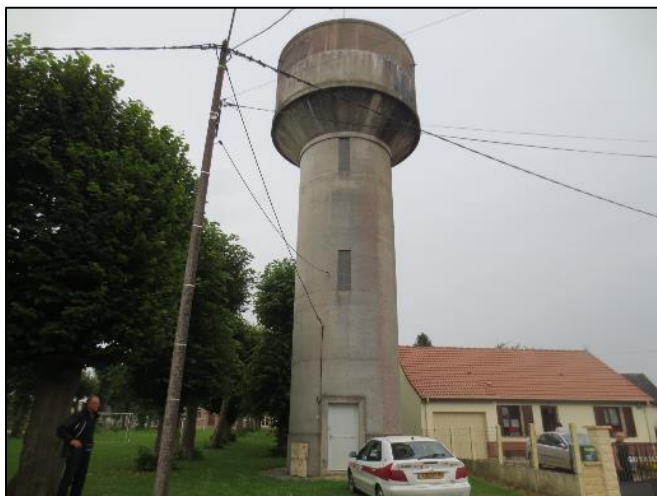
1. Vue générale du site non cloturé
