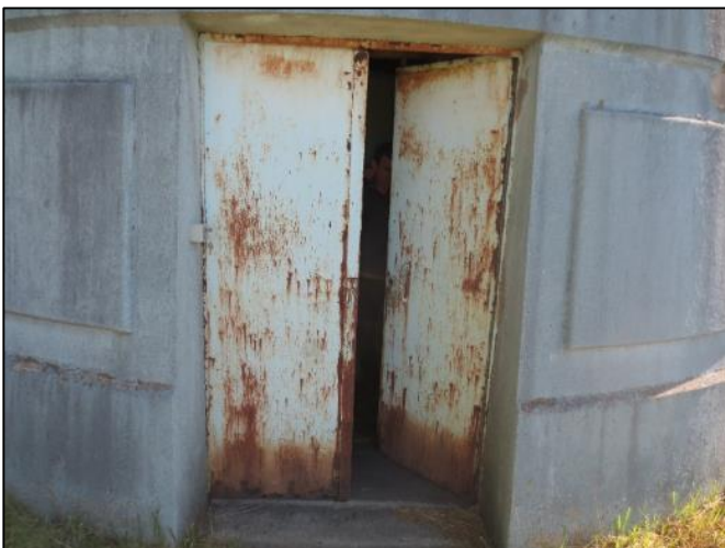
6. Porte d'entrée de l'ouvrage
