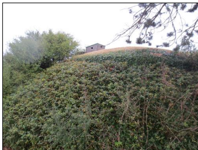
4. Dôme du réservoir végétalisé
