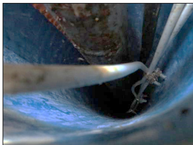
5. Vue intérieure du puits (163 mm)
