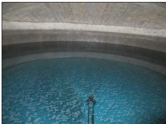
8. Cuve de droite : fond de cuve et crépine de la canalisation de distribution
