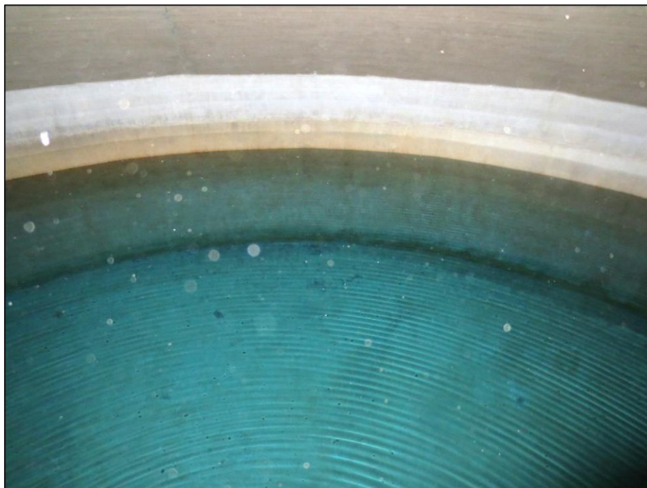
12. Intrados de couple et voile de la cuve en bon état apparent
