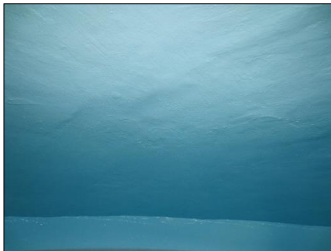
29. Intrados en bon état apparent
