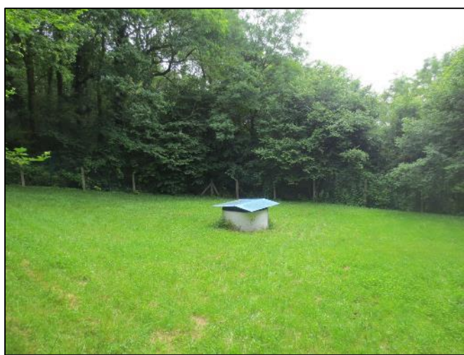
4. Parcelle du forage et tête du puits
