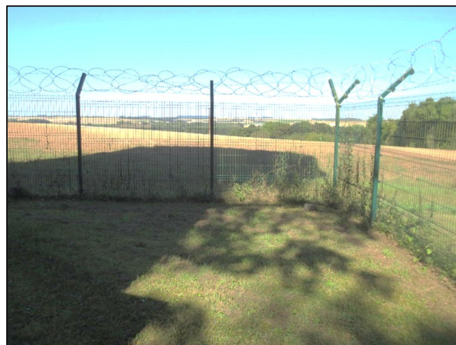
4. Clôtures en bon état et abords bien entretenus
