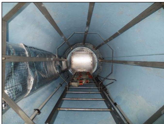
22. Trou d'homme d'accès à la cuve
