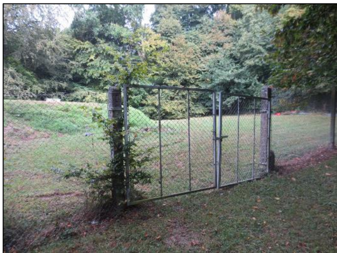
7. Accès aux cuves : portail non verrouillé
