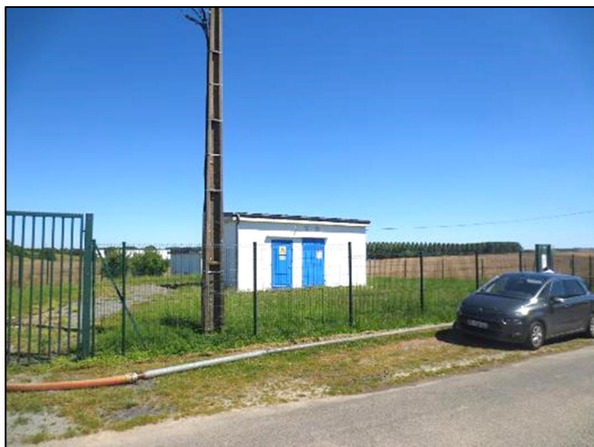
1. Vue générale du site clôturé
