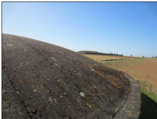
6. Extrados de coupole en bon état apparent
