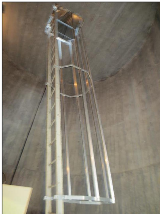
11. Echelle avec crinoline d'accès au 1 er palier
