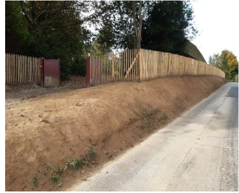
Exemple de clôture en ganivelle admise en haut de talus
