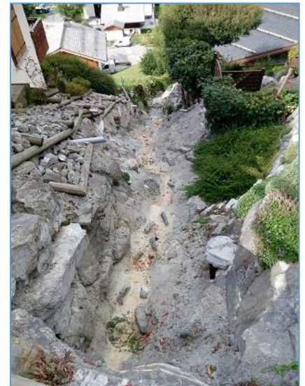
Ruisseau à l'aval du Ø800 de la route Les Encoches 107
