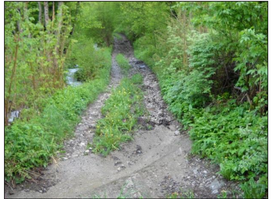
Traversée en béton (renvoi d'eau)
