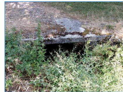
Busage du ruisseau qui traverse Pimberty
