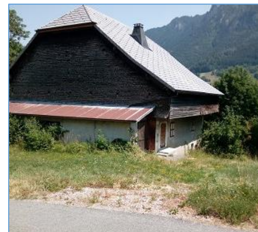
Habitation susceptible d'être inondée
