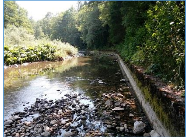
Consolidation des berges du Brévon - Vailly
