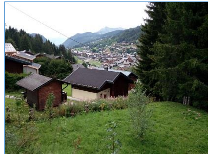
Zone inondée située en contrebas de la route des Chavannes 117
