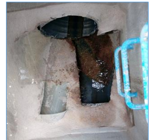
Déversoir d'orage, route du Front de Neige
