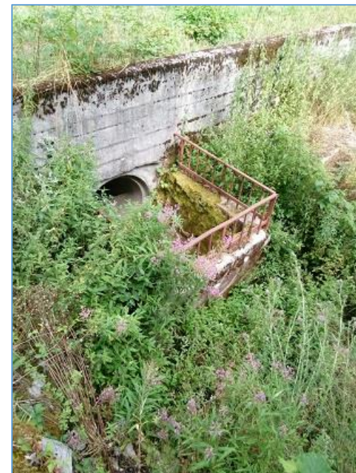
Ouvrage de franchissement de la RD et piège à matériaux
