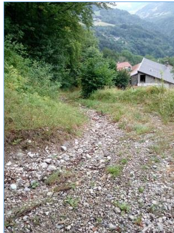
Chemin dirigé vers le hameau recevant des ruissellements amont
