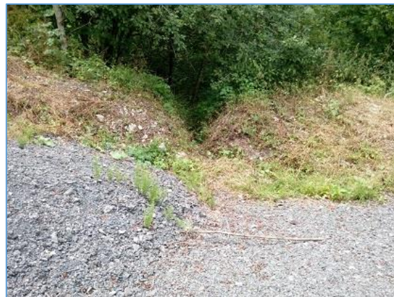
Ouverture permettant aux eaux de voirie de la route de Tréchauffé de se diriger vers le hameau de Rosset
