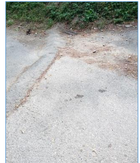
Renvoi d'eau et grille du réseau EP existant
