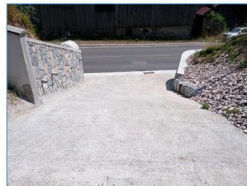
Accès pentu en direction de la RD 26
