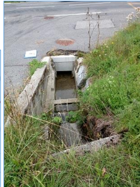
Tête d'aqueduc du ruisseau en amont de la route des Chavannes
