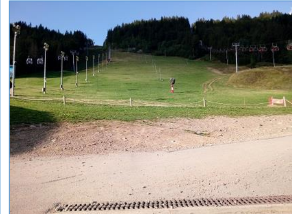
Grille transversale au bas des pistes de ski
