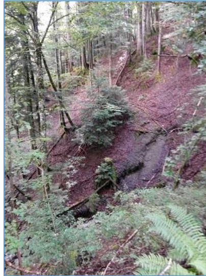
Erosion du ruiseau de la Bride – La Vernaz
