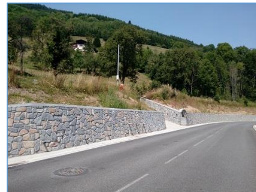
Mur de soutien le long de la RD 26
