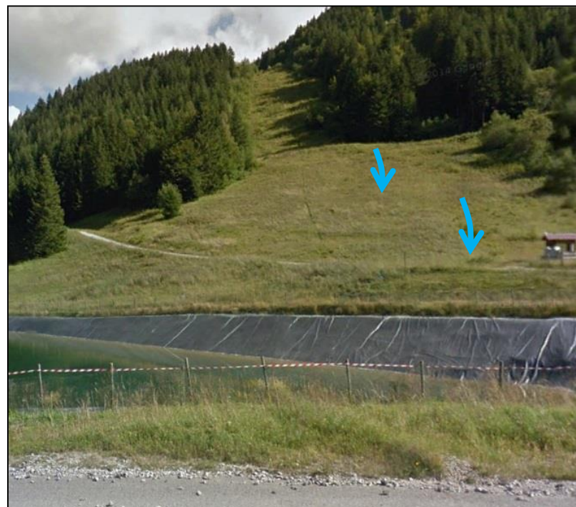
Retenue collinaire existante
