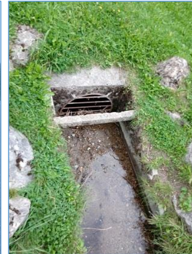
Collecteur Ø500 B situé à l'aval de la zone humide
