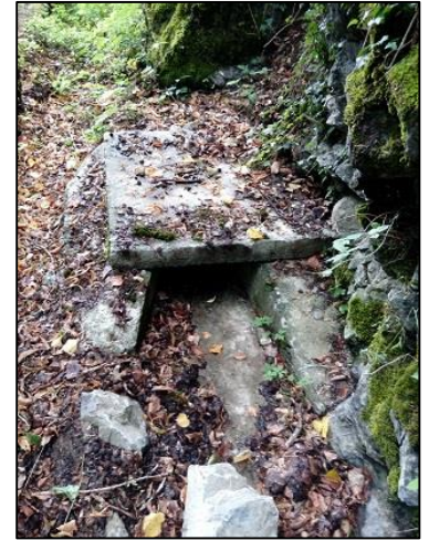
Ouvrage d'entonnement du réseau qui traverse le hameau
