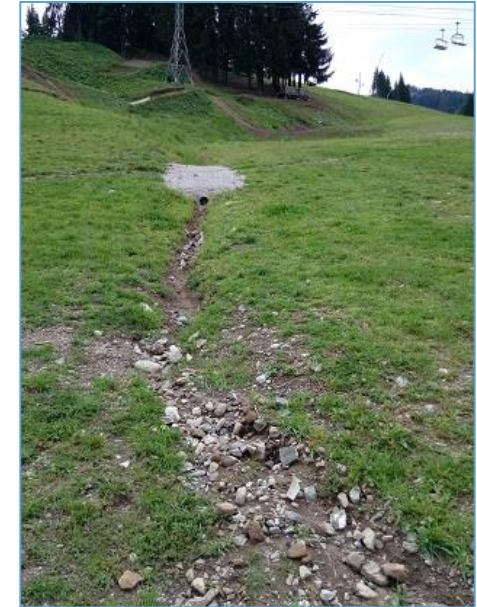
Arrivée d'un drain au bas des pistes de ski
