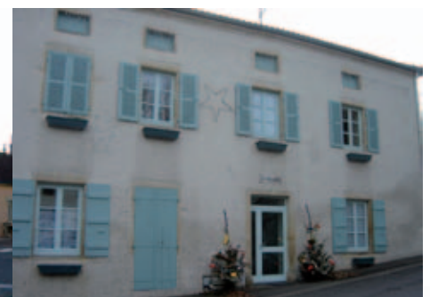
Bâtiments communaux réhabilités en logements locatifs aidés, Melay (71) Maitrise d'ouvrage communale
