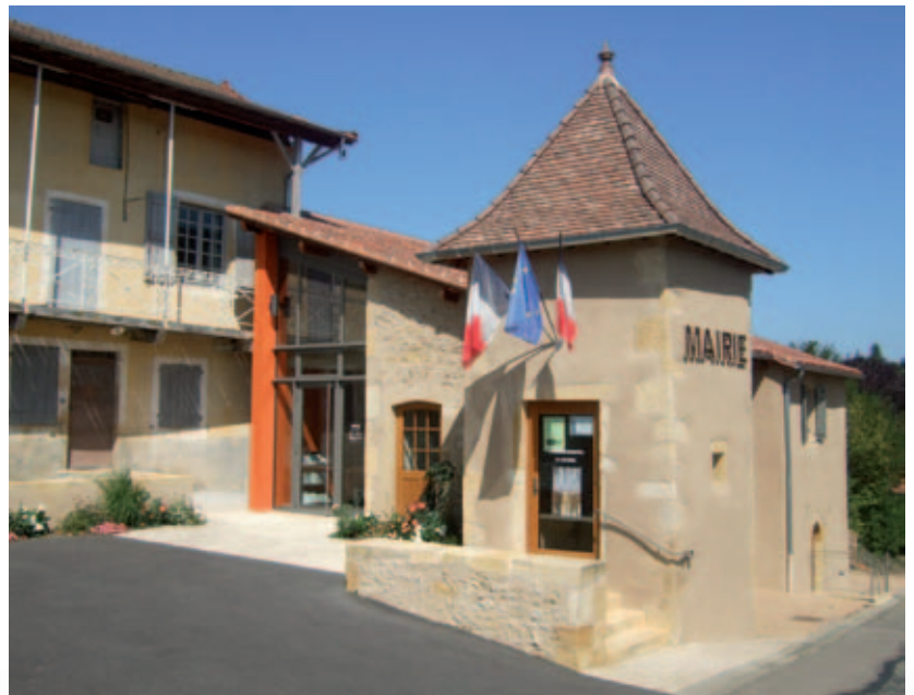
Réhabilitation de la mairie de Saint Bonnet de Cray (71) Keops Architecture (M. Boucaud, M. Vizier)
