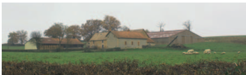
Exemple de bâtiment agricole dans le paysage du Charolais Brionnais
