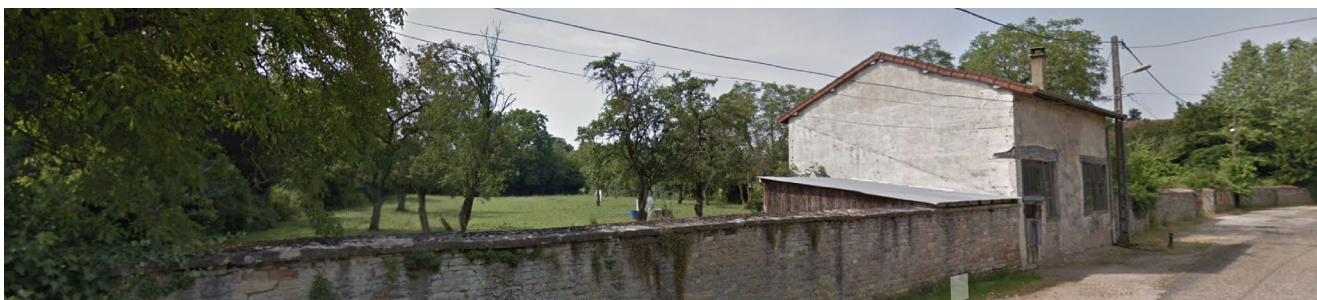
Vue depuis la rue de la tonne, mur existant à conserver
