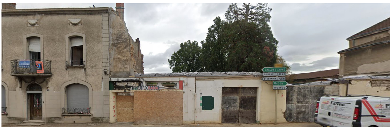
Vue depuis l'avenue du 4 septembre 1944
