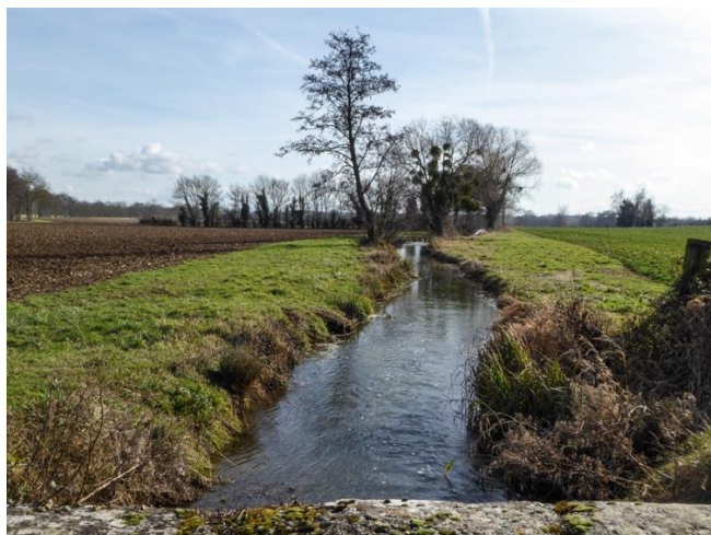
Berge érodée à restaurer (plaine de la Saône) proximité de Saint-Ambreuil.
