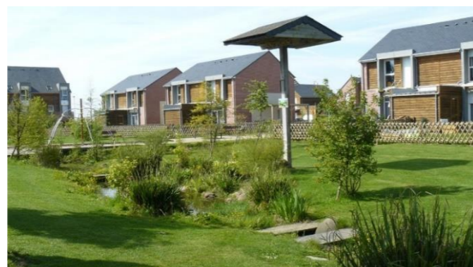
Espace paysager et de gestion des eaux pluviales
