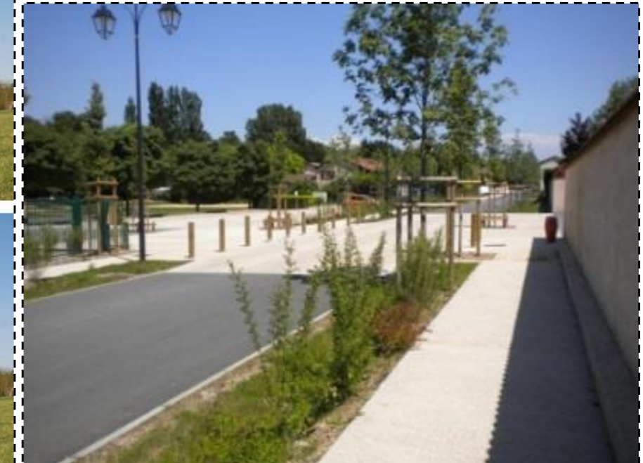
Exemple de traitement et de sécurisation d'une traversée ou d'entrée en secteur urbanisé
