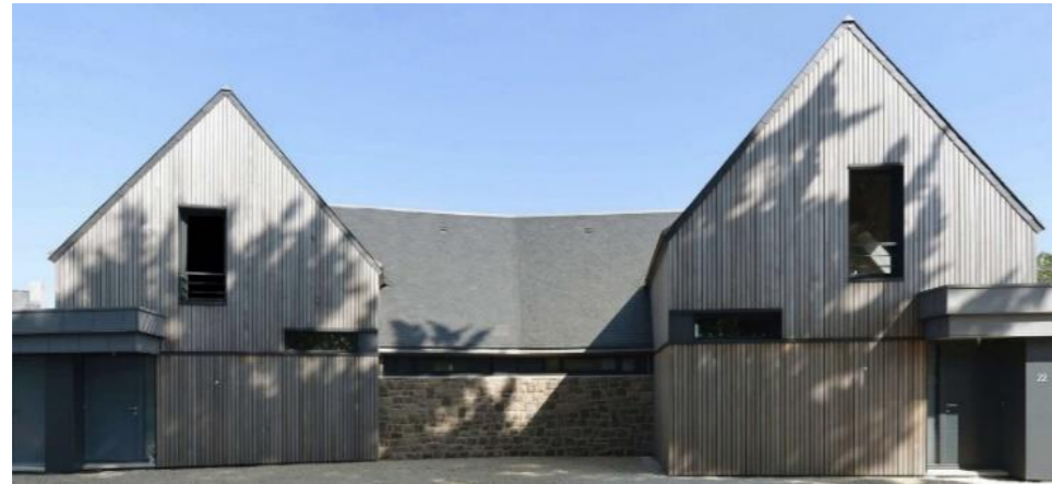
Exemple de maisons mitoyennes ou intermédiaires réinterprétant des styles architecturaux locaux et les volumétries traditionnelles pour garantir une meilleure intégration du bâti dans le tissu urbain existant
