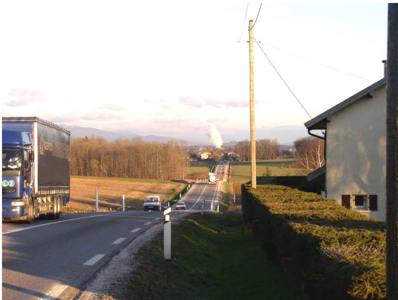
Le débouché de la voie communale n°2 sur la RN 19 en direction de Lure. La visibilité est dégagée.
