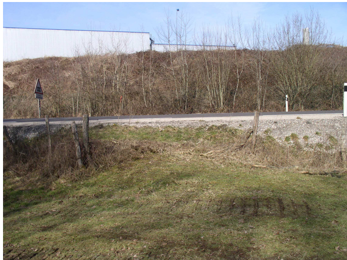
Les talus bordant Isoroy, d'une hauteur de près de 4 m envahis de friches laissent une impression d'abandon.
