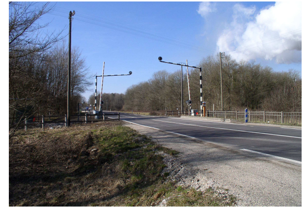
La voie ferrée d'Aillevillers à Lure vue en direction de Vesoul.
