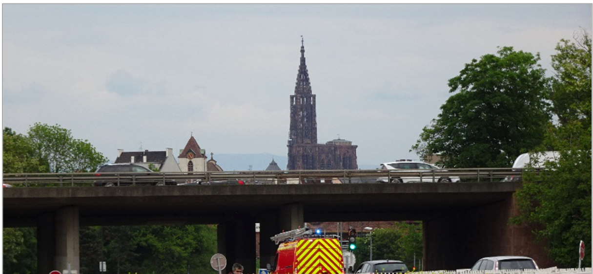
Depuis la route des romains (au niveau de la station de tramway)
