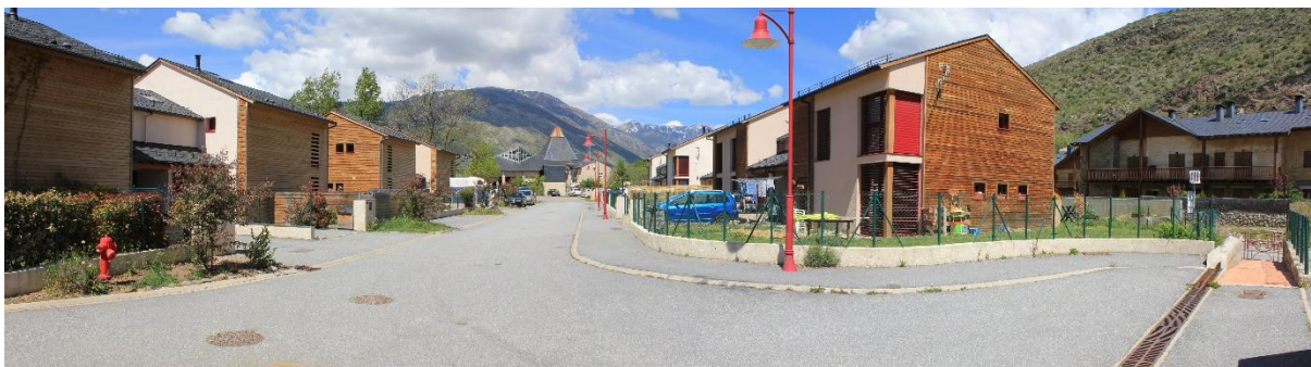
Illustration 12 : Opération de logements à Latour de Carol
