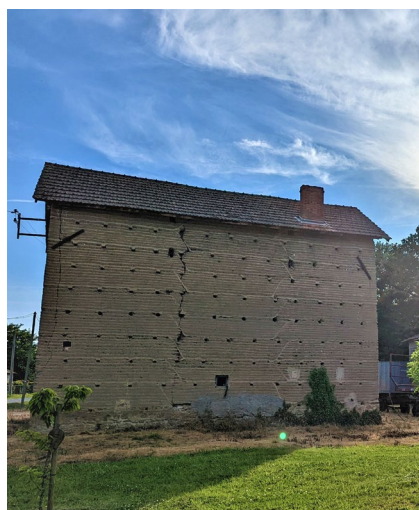
Construction traditionnelle en pisé à Vinzelles
