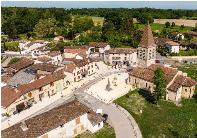
Exemple de la réfection des espaces publics du centre-bourg d'Orléat - © Florian Bompan
