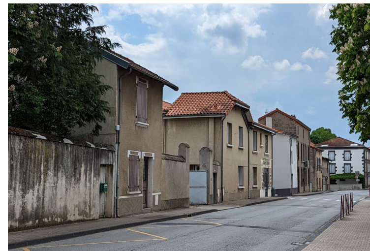
Linéaire bâti à réhabiliter à Joze @Relief urbanisme
