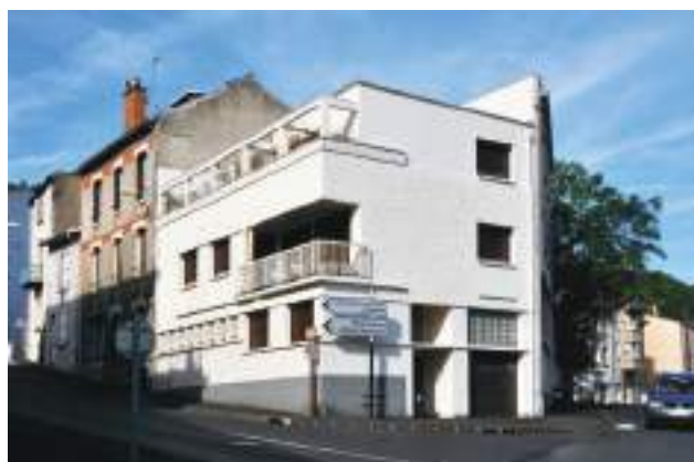
L'architecture des années 1950-1960 nécessite une prise en compte spécifique, notamment pour en identifier les témoignages qu'il serait le plus pertinent de désigner comme patrimoine.
