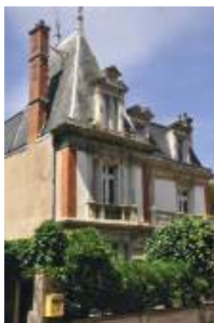
La Renaissance finissante et Louis XIII...
