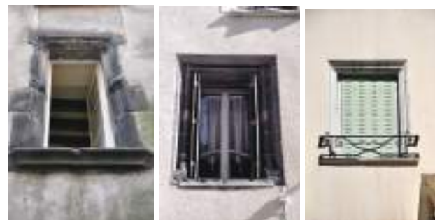
Collection d'ouvertures médiévales ou renaissance avec mouluration. Les deux de gauche ont perdu leur traverse. Celle de droite, plus tardive (début XVIIIe ?) a été réincorporée dans un aménagement moderne (années 1920 ?)
