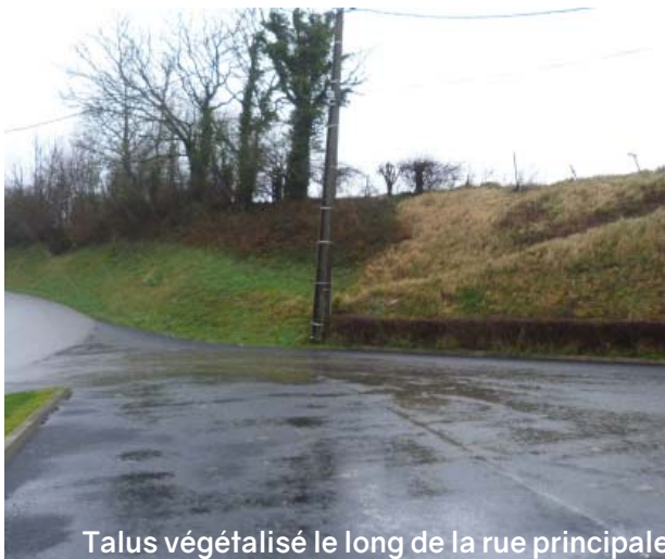
Talus le long de la rue principale
