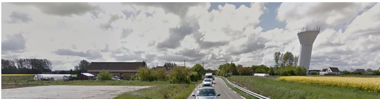
Entrée nord de Nouvelle-Eglise :
