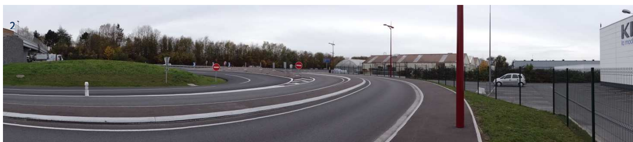
2 La nouvelle bretelle d'accès au niveau de la passerelle Arthur Musmeaux
