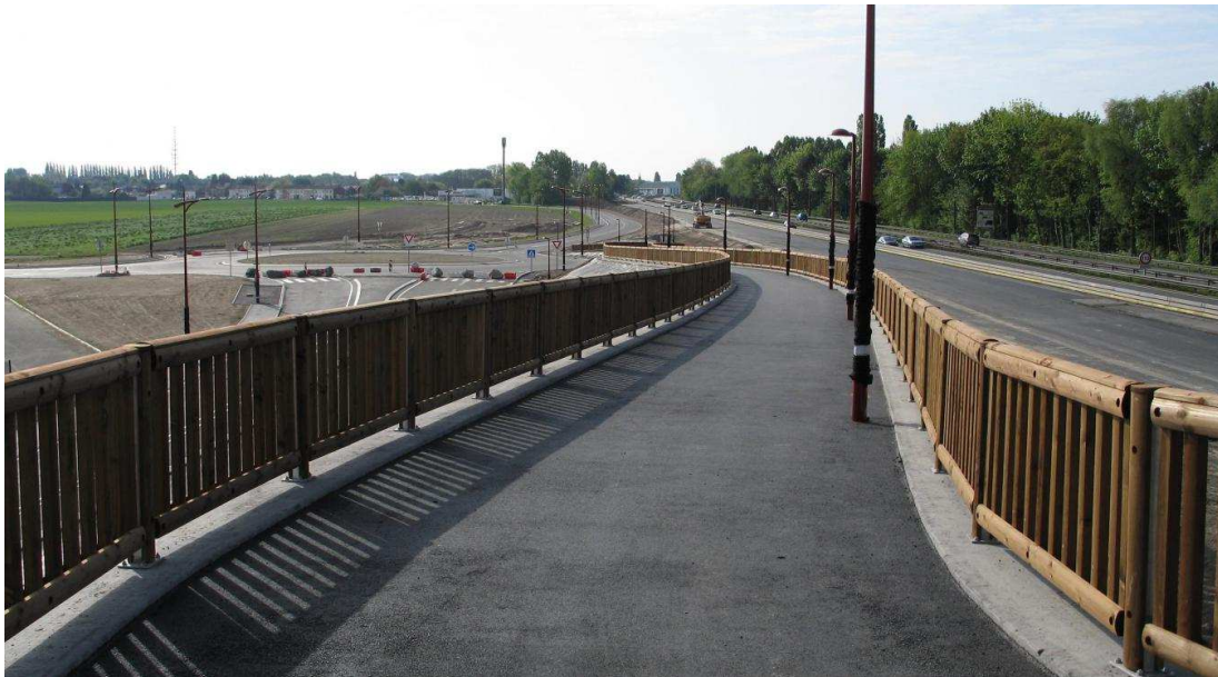
Nouvelle passerelle piétonne traversant l'A23
