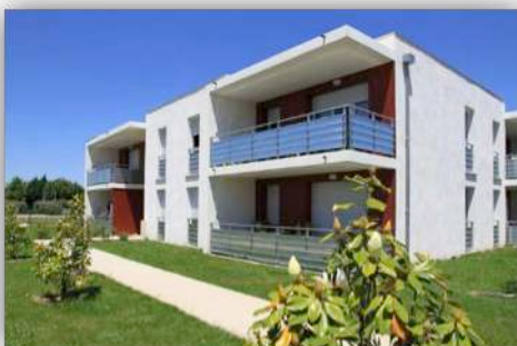
12 logements sociaux intermédiaires à Tournefeuille
