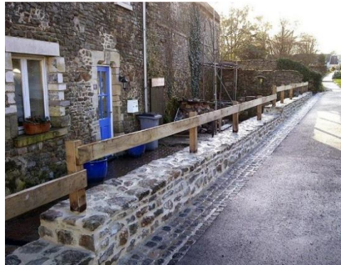
Muret bas et matériaux naturels
