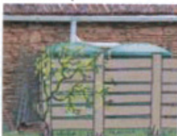
bacs à récupération d'eau
