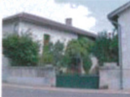
portail en ferronnerie
