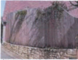
clôture pierre et bois
