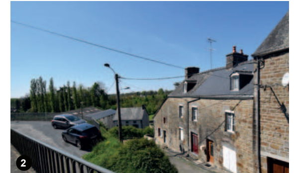
2 Rue de la Tranchée
