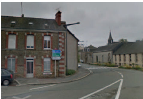
Photographie de l'état actuel
