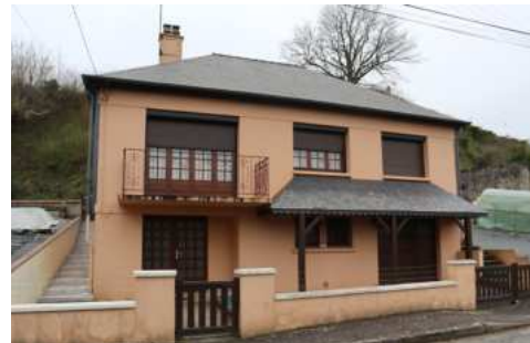
Rue du Moulin à Tan
