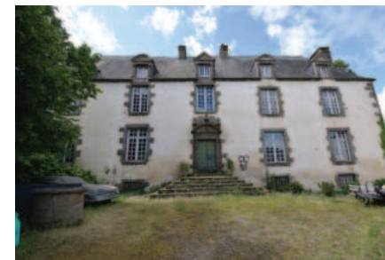
Hôtel de Charnay, façade nord Cliché de C. Chauveau, Hadès, 2022
