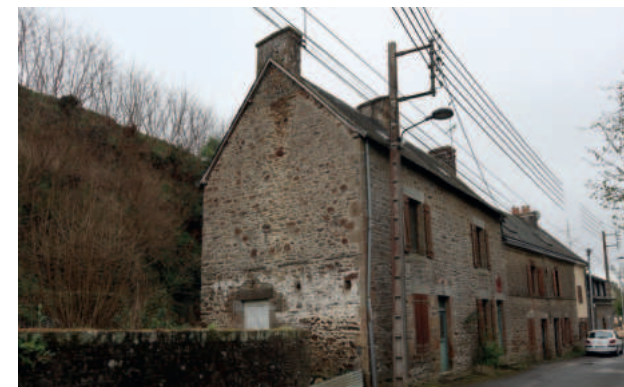
Rue du Moulin à Tan
