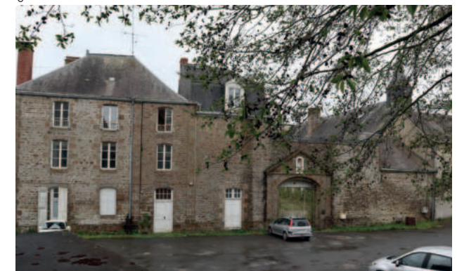
Ancien Couvent, route de l'Hôpital
