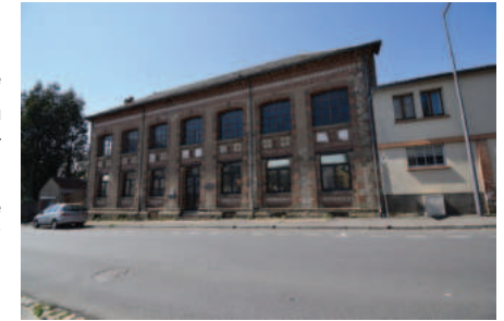
Manufacture de Chaussures de Vital Gallard (bâtiment sud), avenue de la Libération cliché de C. Chauveau, Hadès, 2022
