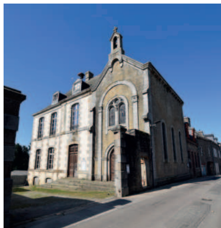
— Hôtel de la miséricorde, façade est (à gauche) et chapelle (à droite) Cliché de C. Chauveau, Hadès, 2022
