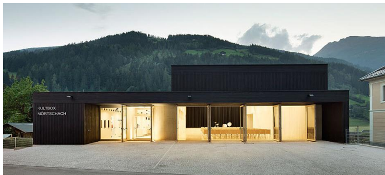
Exemple de bâti écologique et bioclimatique avec de grandes ouvertures (à privilégier sur les façades sud et est) – Source :
