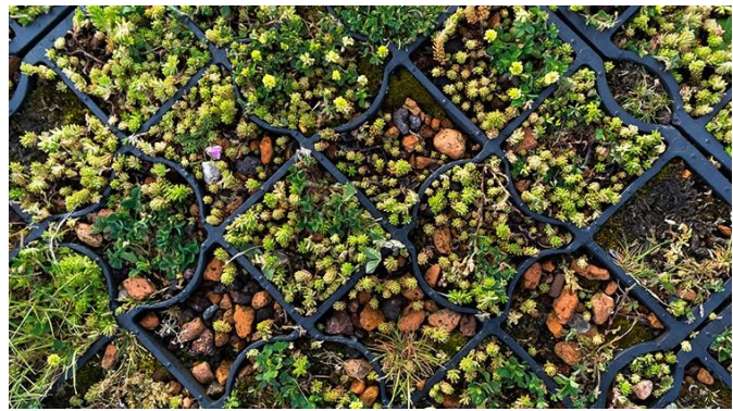
Structure alvéolaire pour perméabilisation des surfaces de stationnement
