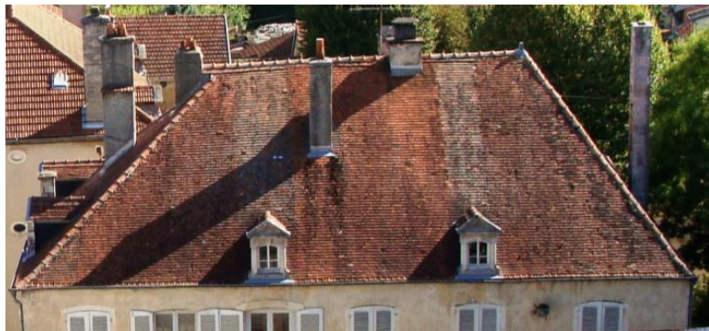
Couverture à quatre pans en petites tuiles plates 4, rue de l'Amiral Décrès
