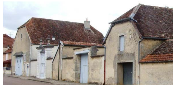
Toiture à croupette rue de l'Amiral Décrès
