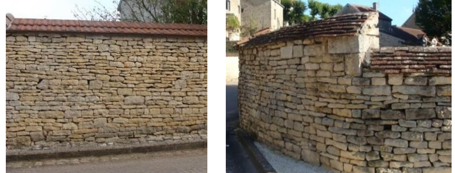
Murs d'assises régulières de pierre calcaire sans joint apparent et couronnement en petites tuiles plates ou en tuiles mécaniques
