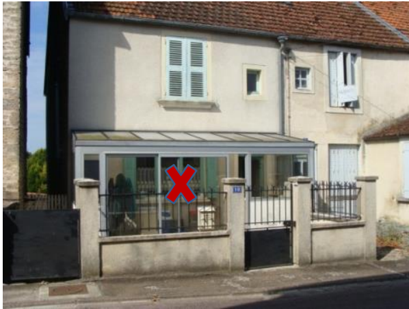
Clôture et véranda en rupture avec la tradition des usoirs
