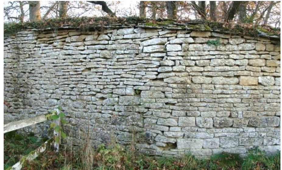
Mur d'enceinte du parc aux daims près de la rue de Richebourg et du couvent des Cordeliers, constitué de belles assises de pierre calcaire sans joint, et d'un couvrement en pierre de lave.
