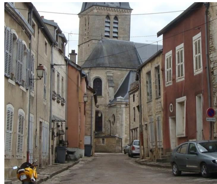
La rue du Prince de Joinville a conservé son tracé médiéval
