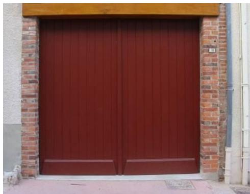
Porte de garage oscillo-battante avec habillage de planches de bois assemblées verticalement
