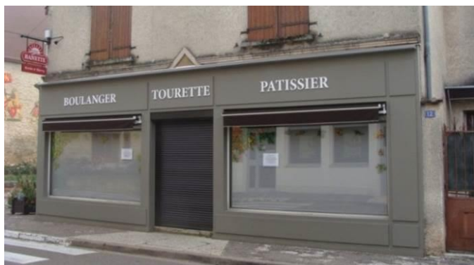
Façade commerciale constituée de panneaux bois en applique 12, rue de Penthièvre
