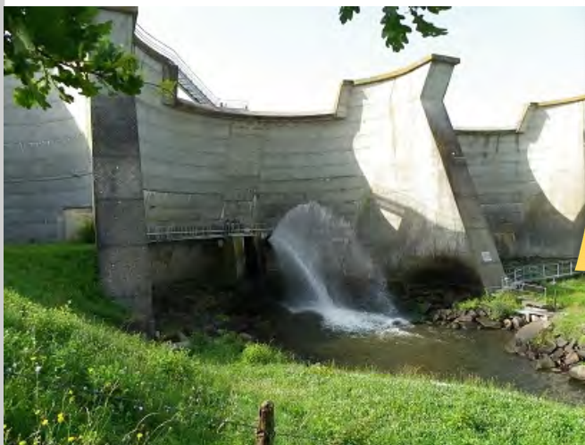
Photo : DDT49 _ Barrage du VERDON
