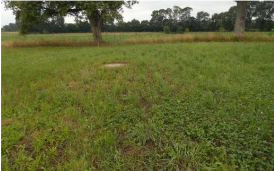
Figure 52 : Puits d'aérage photographié en dans le cadre de la visite d'inspection du 23 juin 2021 par UD49 (L74)
