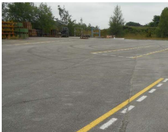
Figure 49 : Localisation possible et estimée du Puits 1 photographié en dans le cadre de la visite d'inspection du 23 juin 2021 par UD49 (L74).
