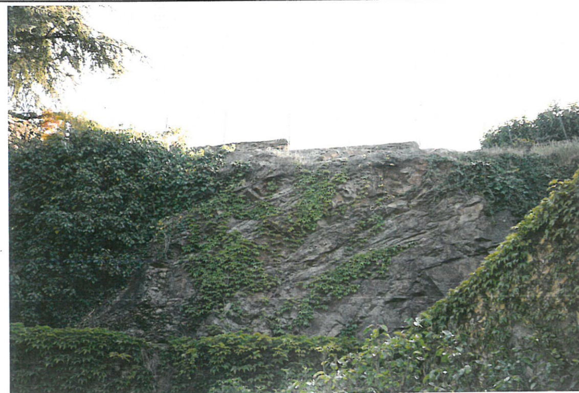
Rue de la Verzée - Vue de la falaise derrière le n° 13 Planche photographique 21
