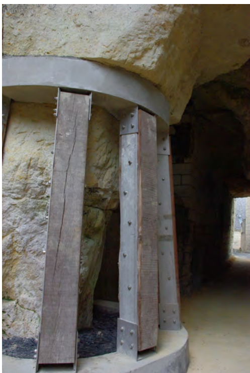
Confortement de piliers à Souzay-Champigny
