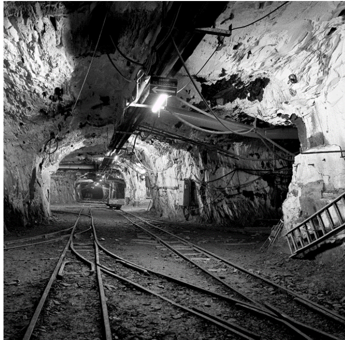
Figure 21 : Galerie collectrice principale au niveau 194 à Misengrain (source P.Cayla)
