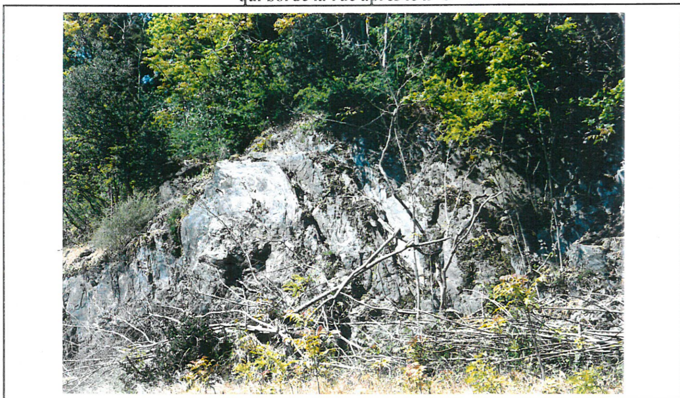
Rue de Mangué - Détail de la falaise de schiste, avec une éaille confortée par un ancrage Planche photographique 13
