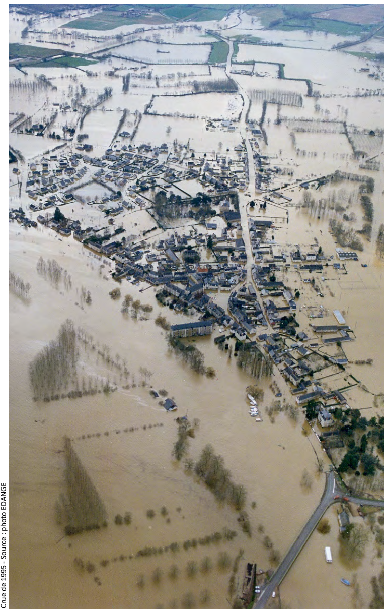
Crue de 1995 - Source : photo EDANGE
