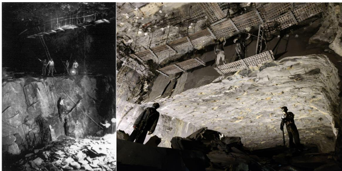
Figure 30 : Méthode descendante sur 6m (figure de gauche) préliminaire à la méthode des bancs à rabattre sur 2m (figure de droite)
