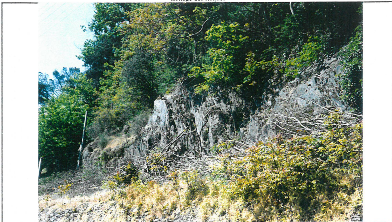
Rue de Maingué - Falaise de schistes en retrait par rapport au mur qui borde la rue après le n° 5
