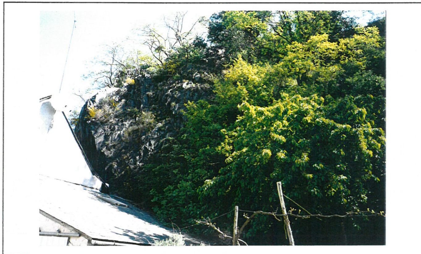
N° 21 de la rue Emile Zola - Vue de la falaise avec le piton rocheux dont sont tombés quelques blocs (limites de propriété n° 19 et 21)
