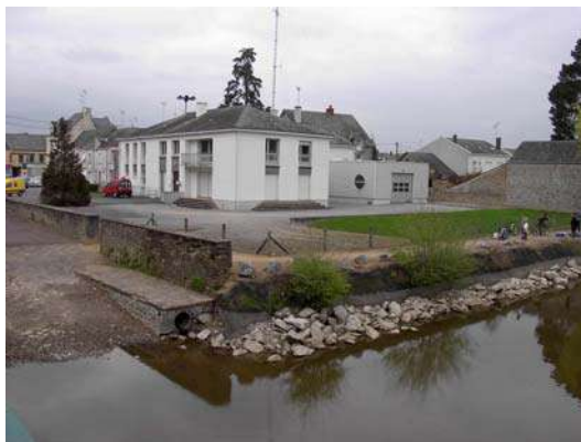
Caserne des pompiers à St-Mars-la-Jaille
