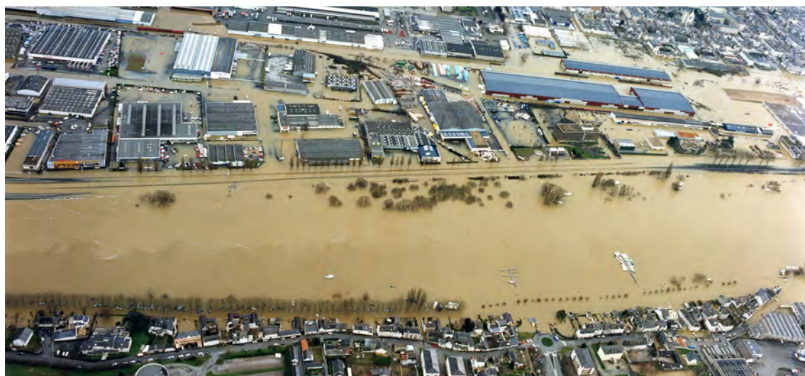
Crue de 1995 - Source : photo EDANGE
