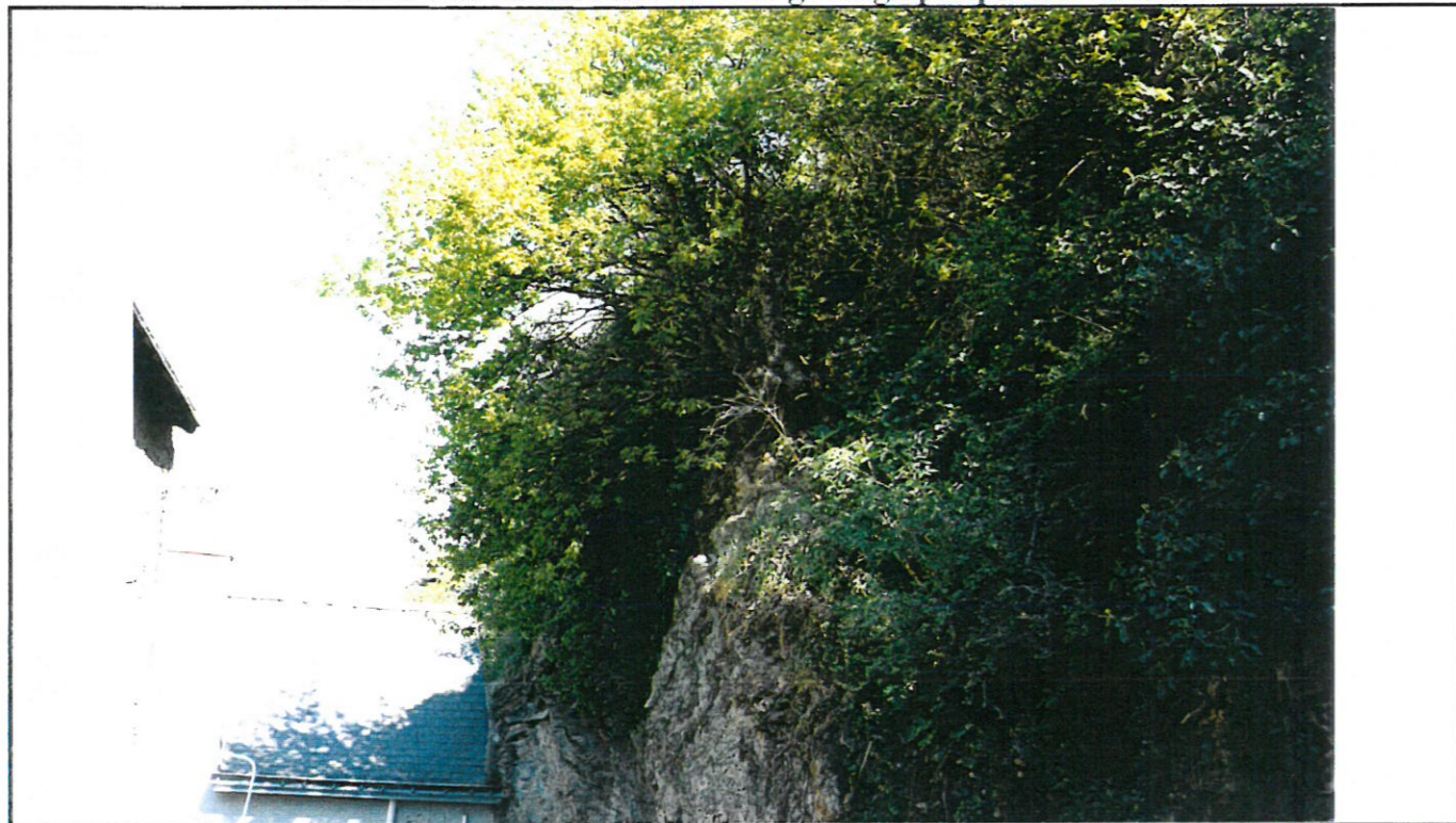
N° 27 - 29 de la rue Emile Zola - Vue de la partie supérieure de falaise, très végétalisée Planche photographique 1
