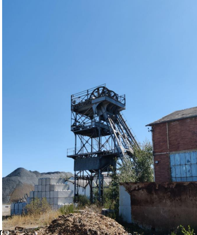
Figure 36 : Chevalement du Puits N°7 de Misengrain (source Mathis Duverger 2022)
