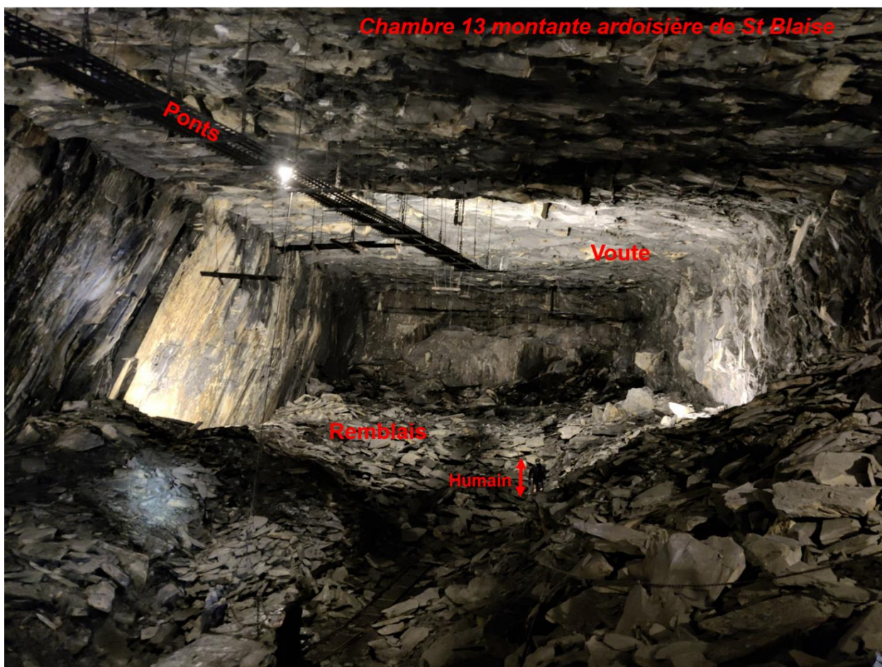
Figure 85 : Photographie de l'intérieur de la chambre 13 de l'exploitation de Saint Blaise (photographie prise par le BRGM en 2022, Mathis DUVERGER, avec l'accord du site de la Mine Bleue)
