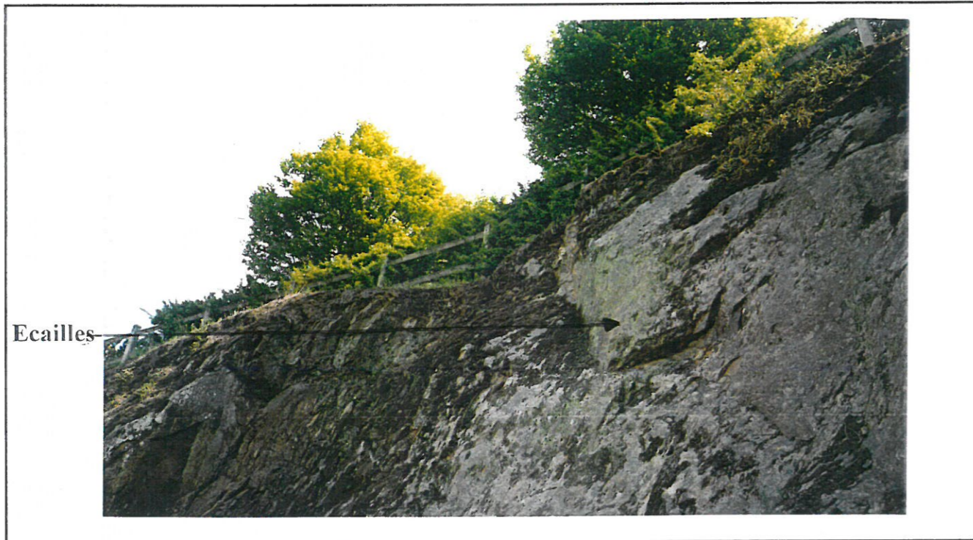
Chemin parallèle à la rue David d'Angers (maison de M. BARON) Planche photographique 26
