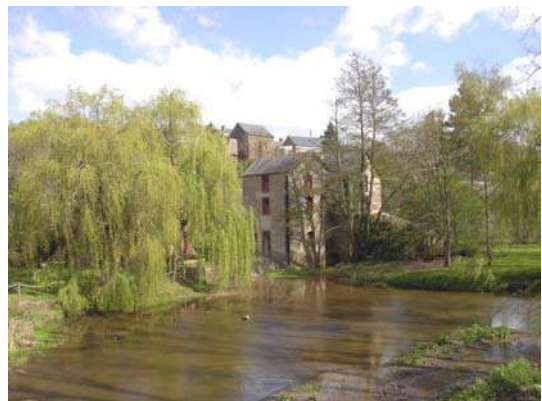
Un ancien moulin sur l'Erdre à Bonnœuvre
