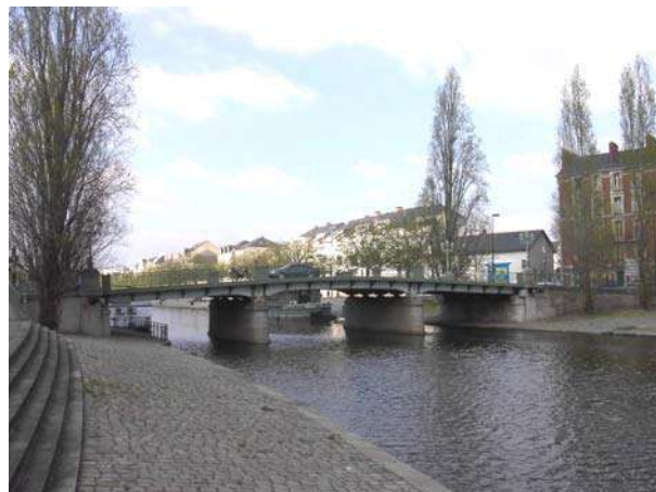
L'Erdre dans la traversée de Nantes
