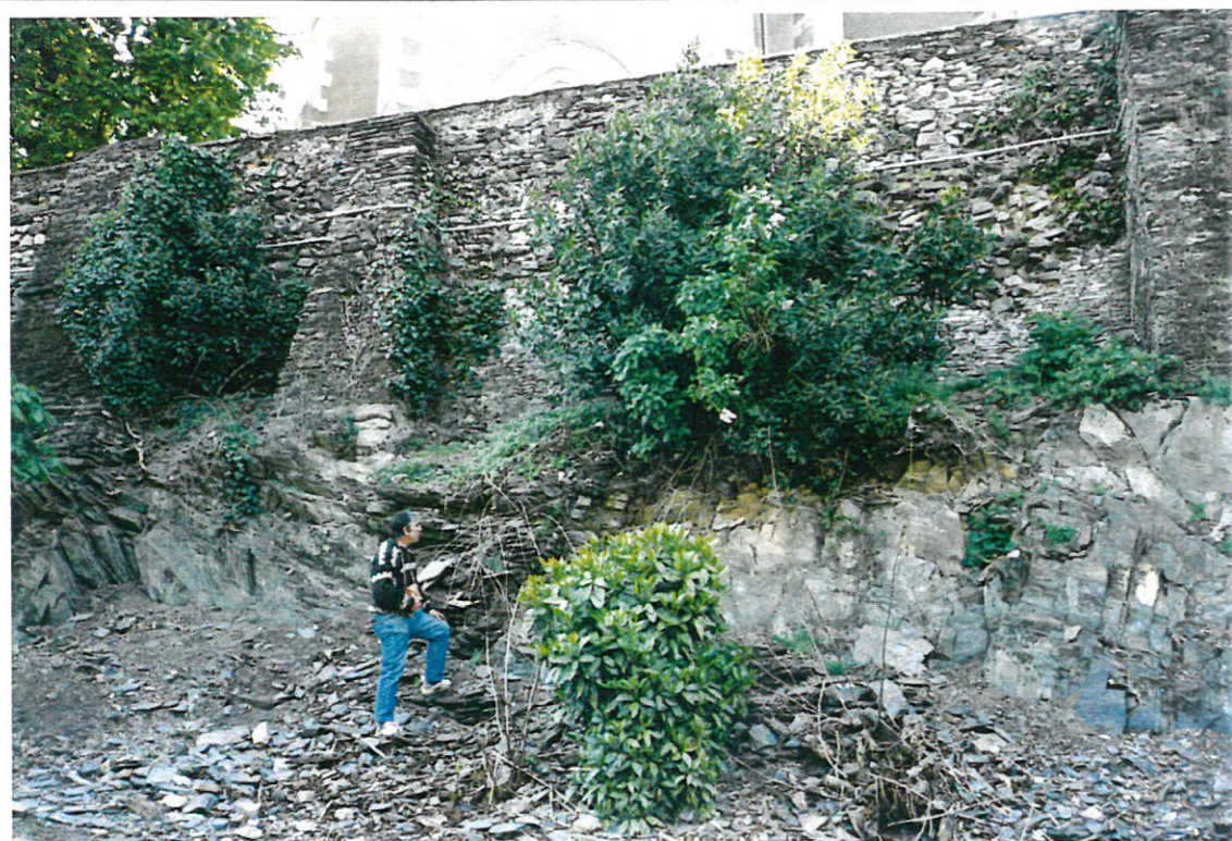
Contreforts de la place de la Chapelle - Vue générale
