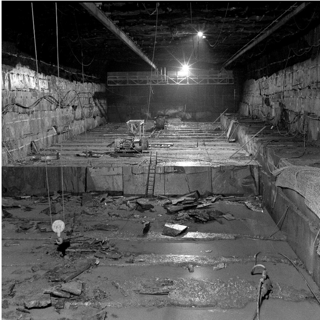
Figure 20 : Chambre descendante N°219 au niveau -194 à Misengrain (source P.Cayla)
