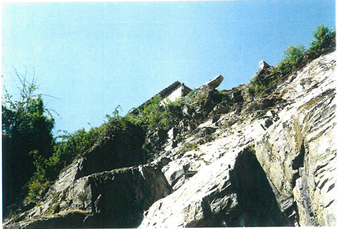
Rue de Maingué - Sommet de la falaise au-dessus des n° 11 et 13 avec traces de l'effondrement le plus récent (garages en surplomb)
