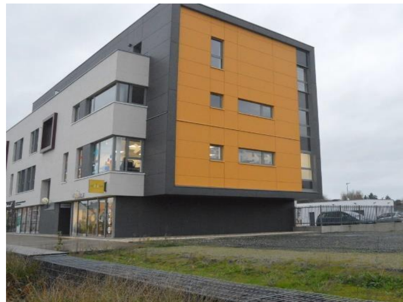
Le Quartier de la gare à Segré
