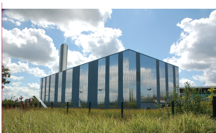
Chaufferie à bois, plateau Mayenne, Angers
