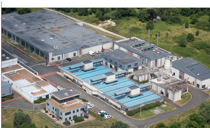
Usine de traitement d'eau potable, Les Ponts-de-Cé
