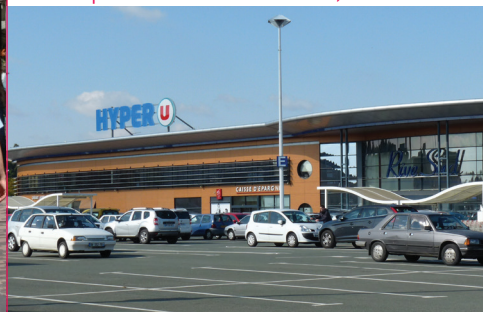
Centre commercial, Rives Sud, Mûrs-Erigné
