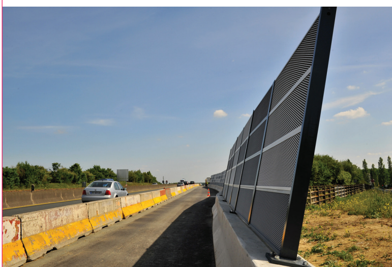
Protections acoustiques le long de l'A87, Angers
