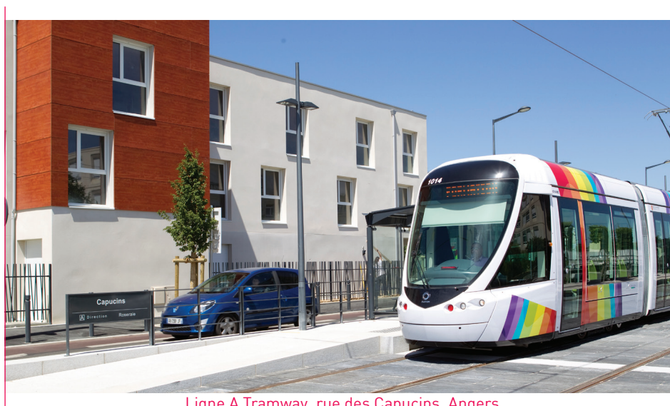
Ligne A Tramway, rue des Capucins, Angers
