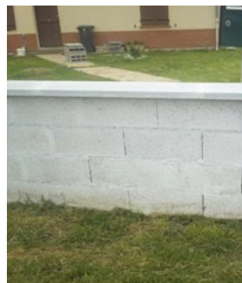
MUR DE CLOTURE NON ENDUIT
