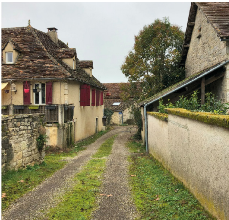
Cheminements et bandes enherbées en pied de façade, Ussel
