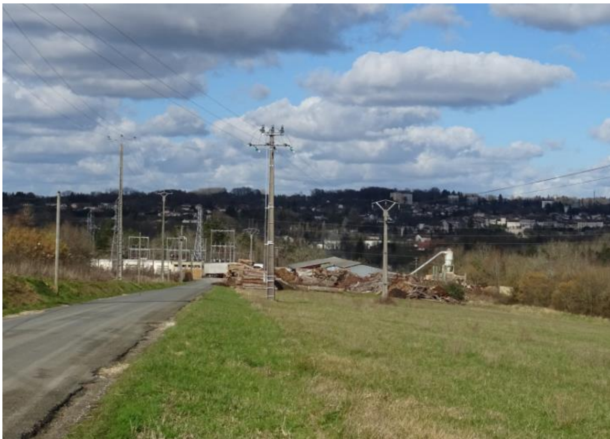
Source : URBAM - Vue depuis le Sud de la Scierie
