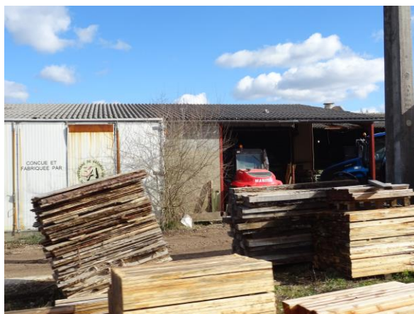
source : visite terrain – URBAM, vue depuis la route « Le Marquisat ».
