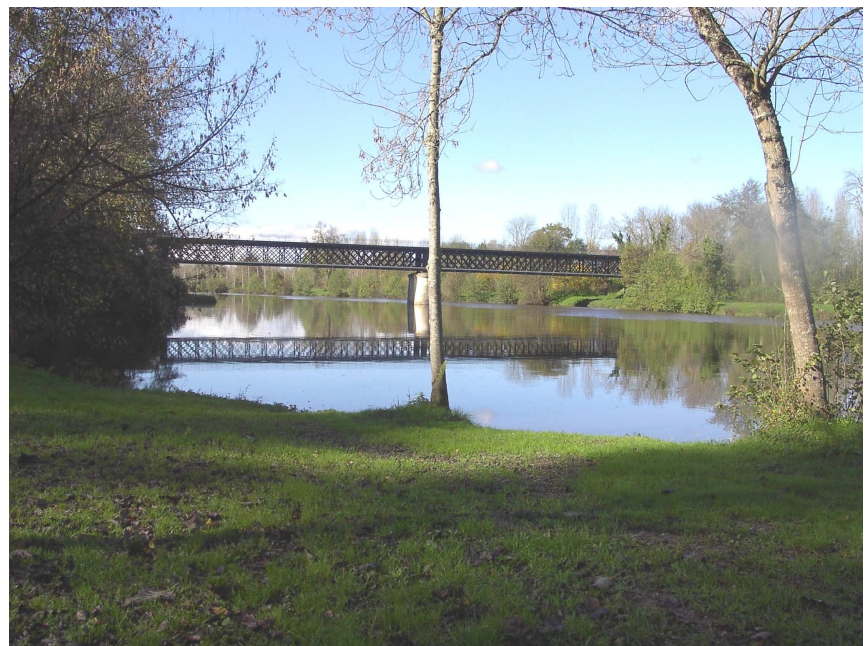
Pont Eiffel reliant St-Louis en l'Isle à Sourzac
